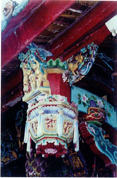
【三川殿步口下之吊筒】
