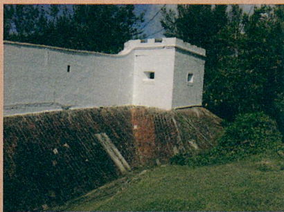
鵝鑾鼻燈塔防衛設施和護塔溝。
