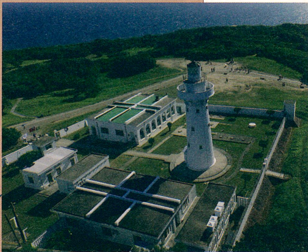
空拍圖中可見到房舍頂上的儲水設備。 (江敬業空中攝影)
