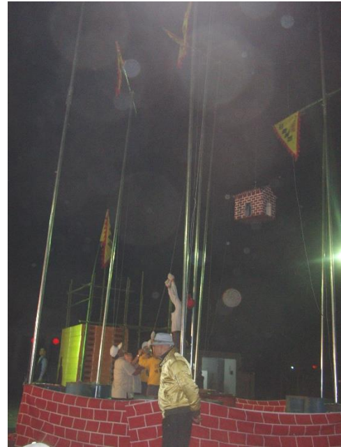
圖 4-11-2 2006 年鋁管為支架材料連接方式搭十二米高炮竿底部用汽油桶當支架
