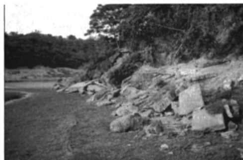
照片一：殘破但巨大的水泥塊散置
