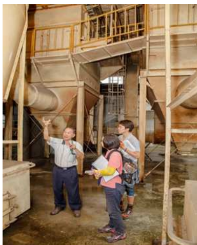
圖 7-24：於菸葉廠集塵區進行導覽，圖左解說廠內的集塵設備，圖右則對其中的旋風式集塵器進行科普講解與道具操作。
