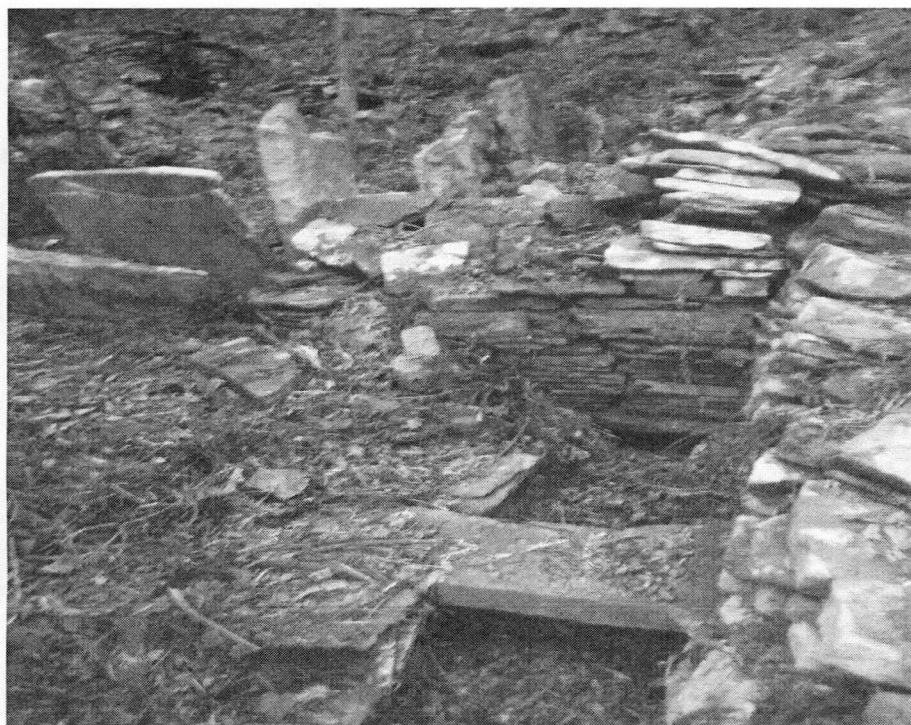
照片 4：家屋右側豬舍排水溝
