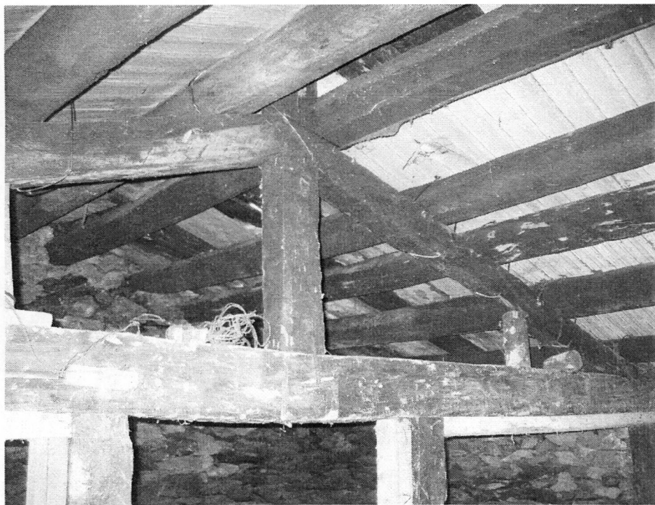
照片 4：家屋屋樑結構
