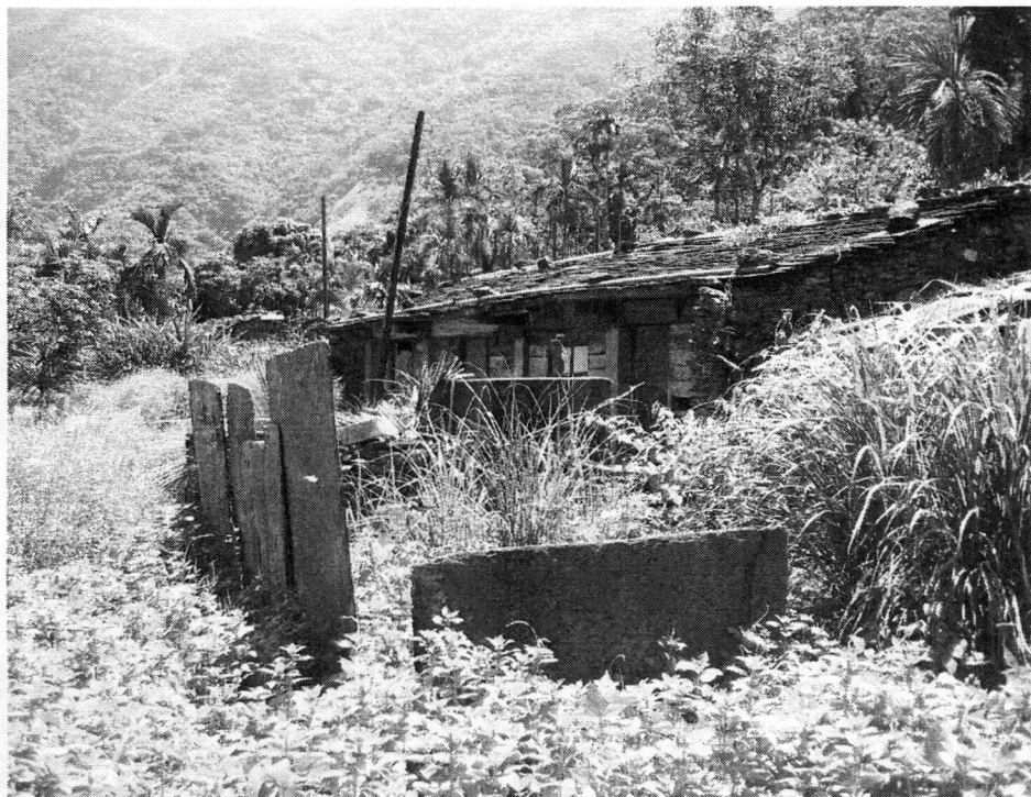
照片 3：達來舊社保存完整的家屋遺址
