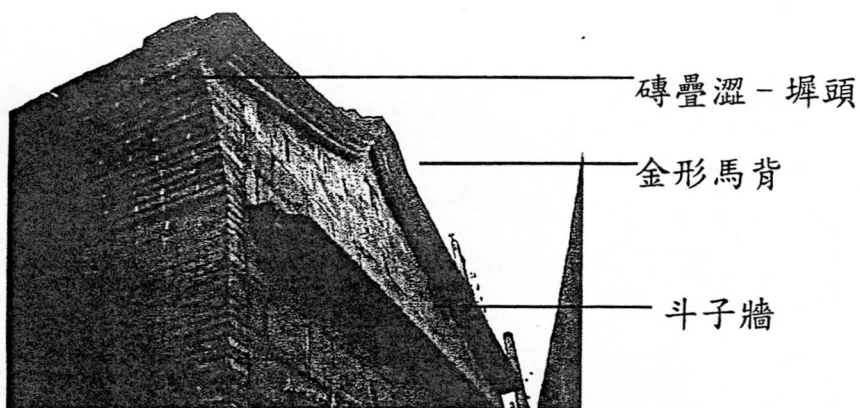
圖 7 懷忠門牆面構造
