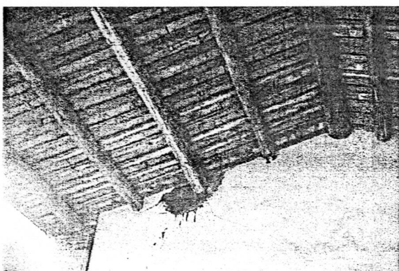
圖 9 承重牆構造式屋架
