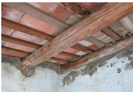
相4-1-97左側入口檁沿構材方向裂縫及蟲蛀
