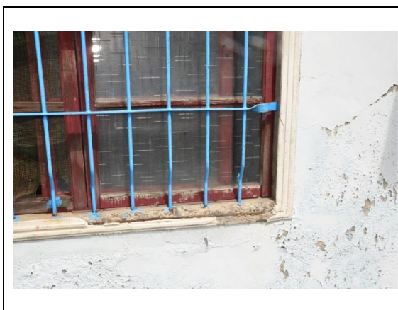
相5-2-25. 右廊下窗戶之窗框、窗扇腐朽破損嚴重，應予以拆卸清潔後填補修復，並將新制鐵柵欄拆除
