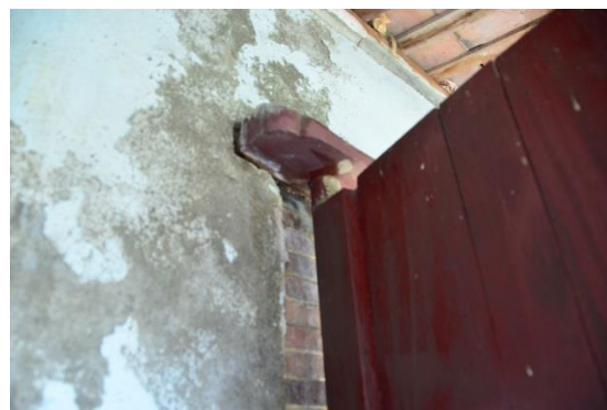
相5-2-13. 外牆灰泥粉刷層風化剝落，應將表面粉刷層全部手工鑿除，清潔後予以填補加固
