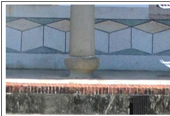
相3-3-29 柱珠位於柱子底部，以石塊製成
