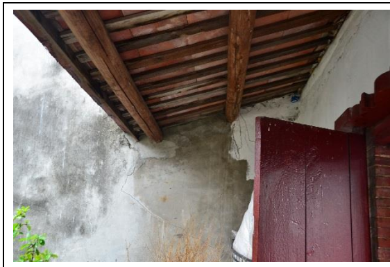
相3-3-17 右山牆汗濁龜裂，部分牆面有油漆粉刷修補痕跡
