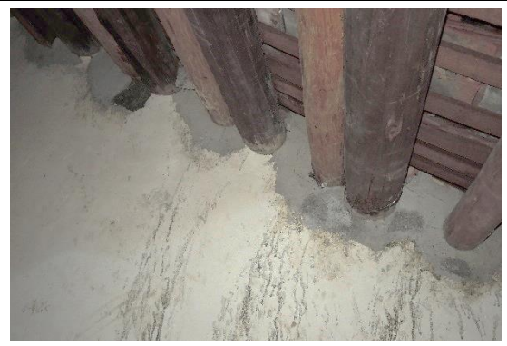
相3-3-88 正身部分屋架增設桁木補強結構
