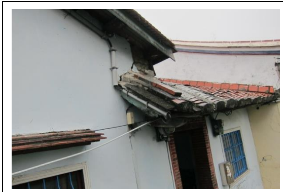
相4-1-133左廊下背牆出簷處裂縫屋面變形
