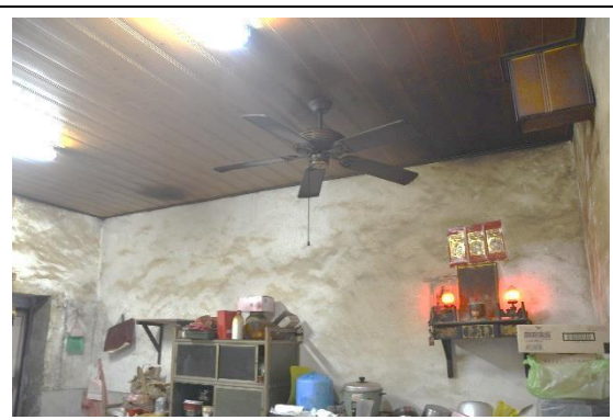
相3-3-86 第四戶牆面表面粉刷層多處浮凸軟化
