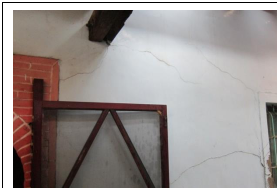
相4-1-119左橫屋東廳北側出簷斗拱下方牆裂縫
