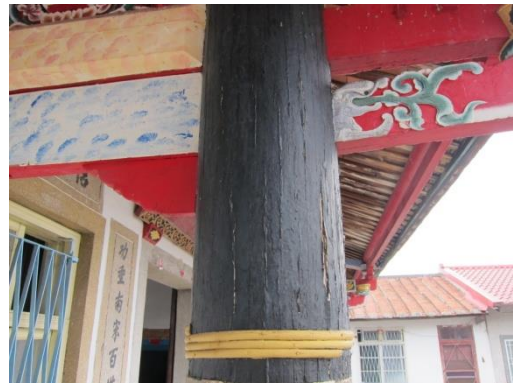
相4-1-52前堂檐廊右側廊柱漆繪裂及藤箍斷裂
