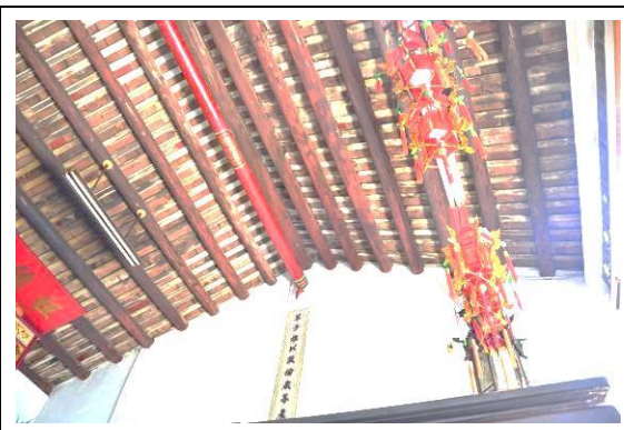
相3-3-66 廳下屋頂檁木部分煙燻汙濁，表面油漆褪色，且有劈裂之痕跡
