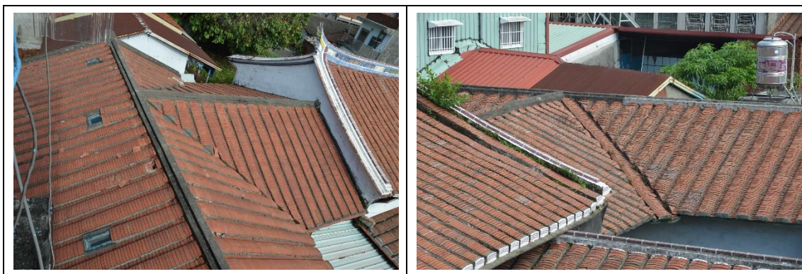
相3-3-75 第四戶屋面局部設有採光設施，屋面銜接處以無轉溝跡象
