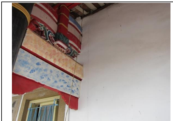
相4-1-35前堂面牆左間仔牆體垂直方向裂縫
