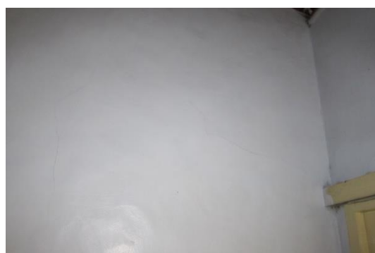
相4-1-157右廊下旁間仔面牆門窗間牆體裂縫 相4-1-158右橫屋西廳南側間仔隔間牆裂縫
