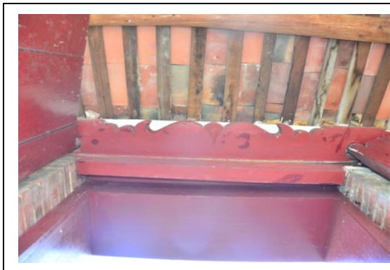
相4-1-149右橫屋騎馬廊入口望磚漏水痕跡
