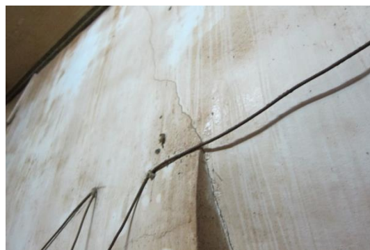
相4-1-155右騎馬廊入口門楣腐朽及補強與牆裂縫 相4-1-156右廊下旁間仔面牆裂縫至門角隅
