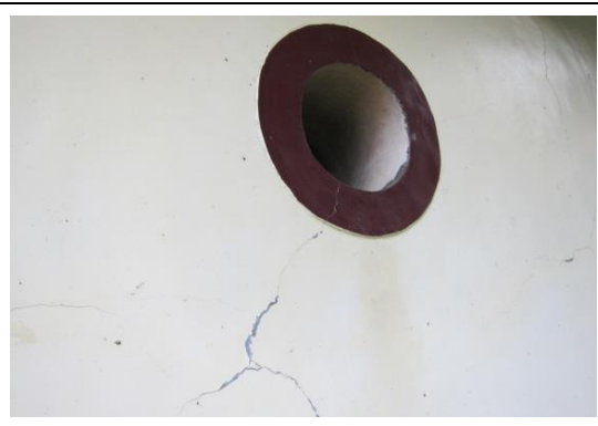
相4-1-80後堂背牆廳下右側通氣口裂縫
