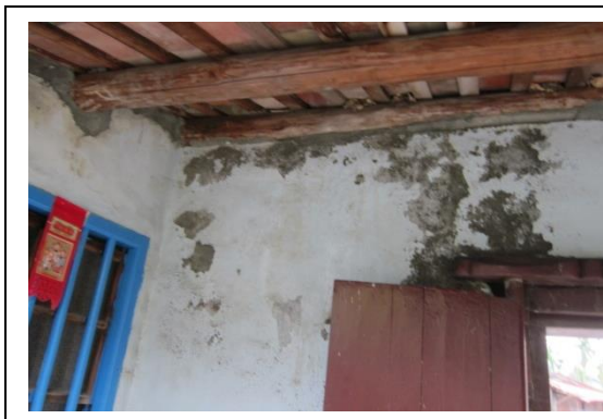
相4-1-135左騎馬廊入口牆油漆剝落
