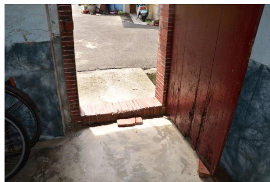
相5-2-20. 左廊下門板腐朽破損嚴重，應將表面腐朽處全部手工鑿除，清潔後予以填補加固
