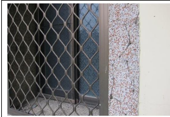
相4-1-87後前左正身間空間背牆窗戶週邊洗石子破裂
