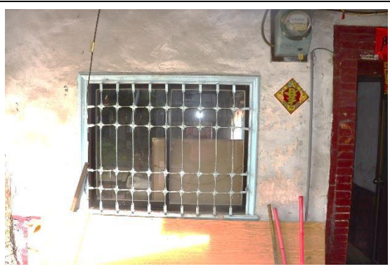
相3-3-54 右廊下後立面，牆體受潮浮凸嚴 重、粉刷層多處脫落
