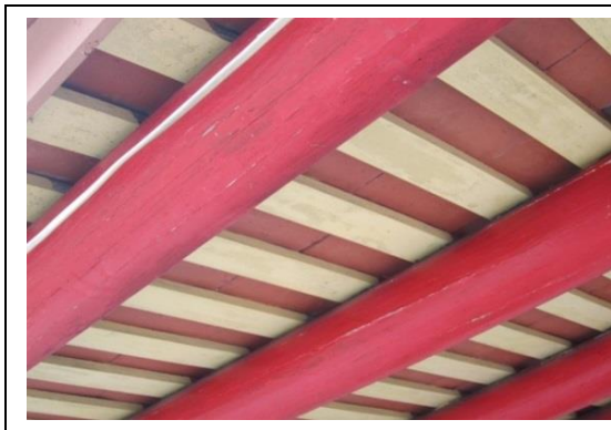
相4-1-1 門樓檁木料沿構材方向裂縫
