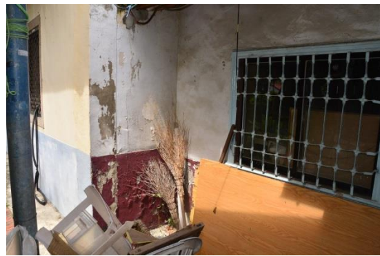
相5-2-12. 後堂廊下外牆受潮浮凸，粉刷層剝落，應予以清潔後填補修復
