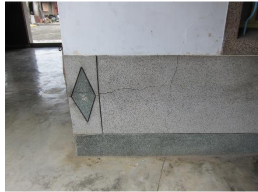
相4-1-38前堂背牆右間仔牆體垂直方向裂縫及水平方向裂縫
