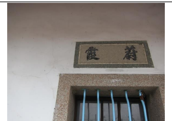
相4-1-36前堂面牆右間仔牆體開窗處斜向裂及垂直方向裂縫
