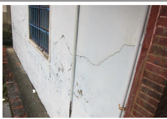
相4-1-134左橫屋山牆裂縫及漆塗剝落
