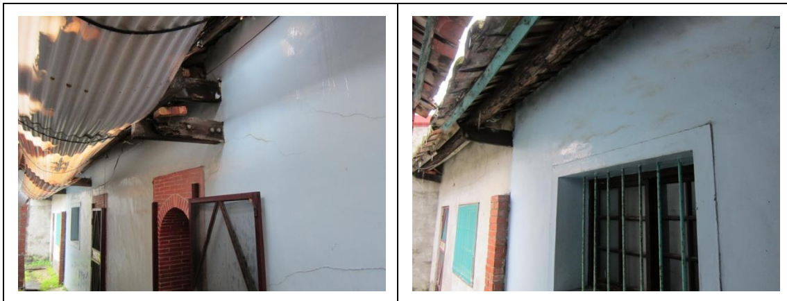
相4-1-99左橫屋背牆東廳出簷構造腐朽損壞修補情形及牆面裂縫 相4-1-100左橫屋東廳南側間仔背牆出簷檁腐朽
