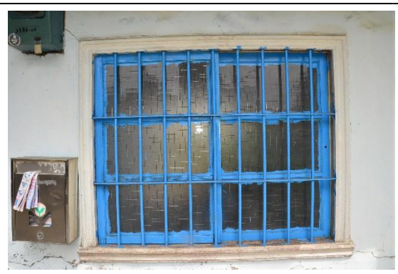
相3-3-80 W5 保留原制構件，抹以油漆維護，輕微汙濁劈裂
