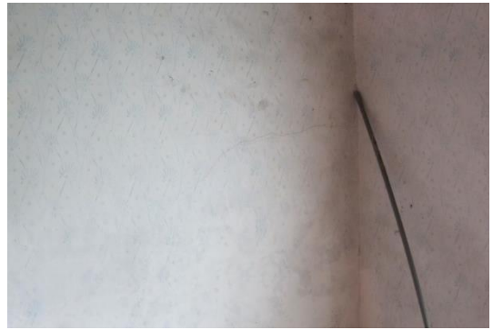
相4-1-122左橫屋臨禾埕間仔隔間牆水平裂縫
