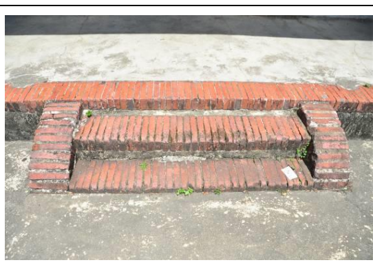
相3-2-2 前堂步檐階梯為磚砌之踏階，因地坪有加高，第三階有部分已埋於地面下
