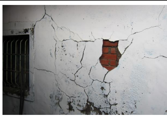
相4-1-138左橫屋東廳北側間仔背牆裂縫及間仔 後門砌磚封閉及漆塗剝落
