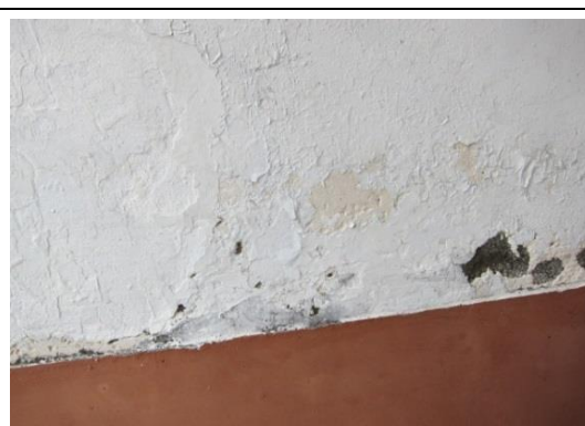
相4-1-6 門樓兩側牆多處粉底層及面漆脫落
