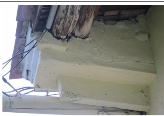
相4-1-70後堂左正身間空間背牆出簷之檁腐朽及現況出挑構件為 RC
