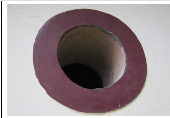
相4-1-79後堂背牆廳下左側通氣口裂縫
