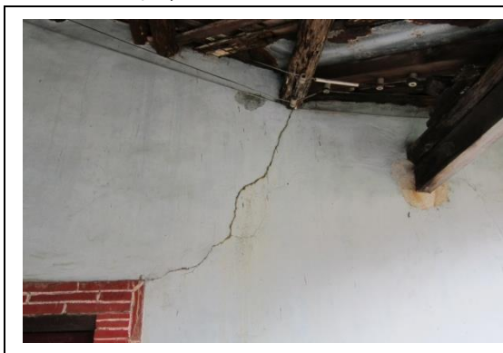
相4-1-111左橫屋廊下間仔裂縫由櫟下方裂縫至 相4-1-112左橫屋廊下間仔門與窗戶間裂縫 1 開門角隅
