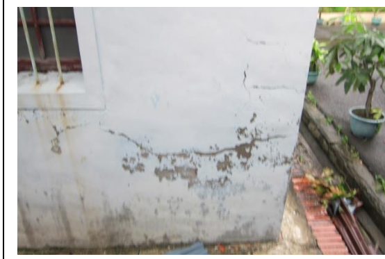
相4-1-115左橫屋背牆裂縫及漆塗剝落
