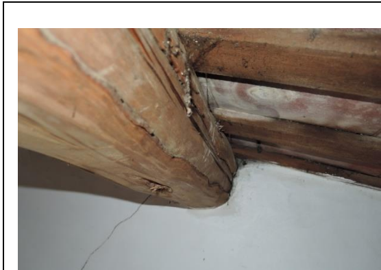
相4-1-149右橫屋騎馬廊入口望磚漏水痕跡
