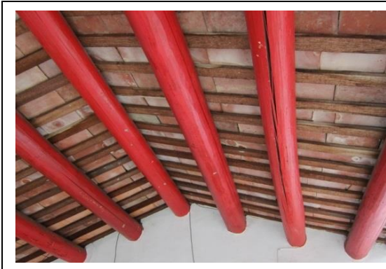
相4-1-57左廊檁沿構材方向裂縫
