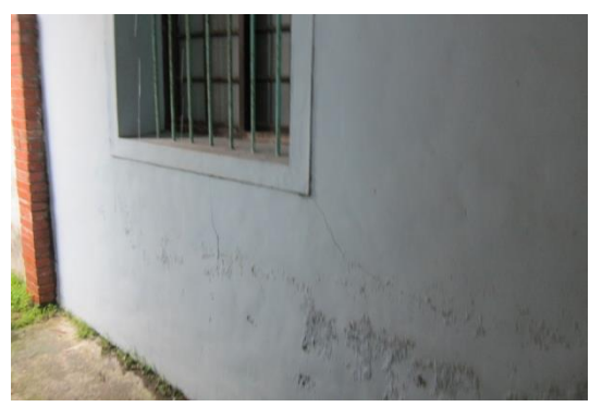
相4-1-118左橫屋東廳南側間仔背牆窗戶角隅裂縫及漆塗剝落
