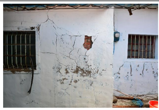
相3-3-84 第一戶背立面牆身表面粉刷層破損剝落，露出內部磚牆結構
