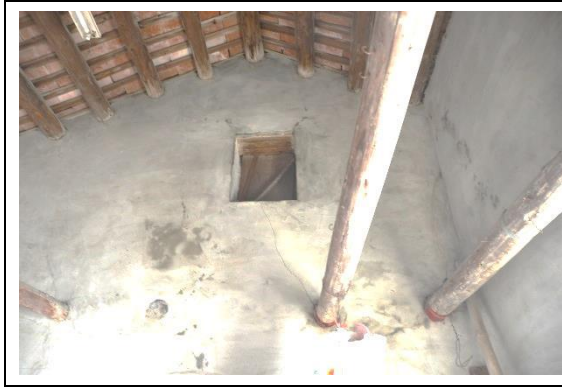
相3-3-15 左間仔高窗以磚砌填實，牆面受潮汗濁、斑駁龜裂
