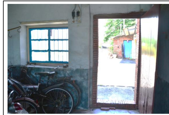
相3-3-57 左廊下牆面多處斑駁浮凸、牆面漆料 剝離
