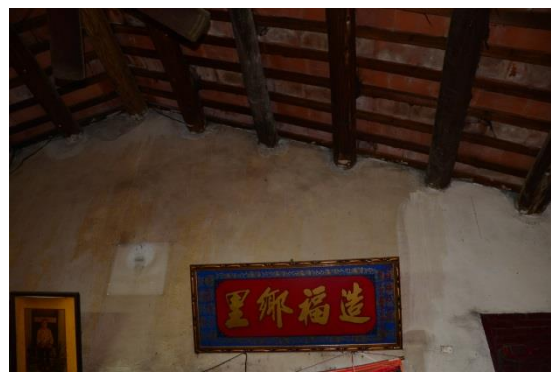
相5-2-14. 內牆表面粉刷層浮凸剝落，應將表面粉刷層全部手工鑿除，清潔後予以填補加固
