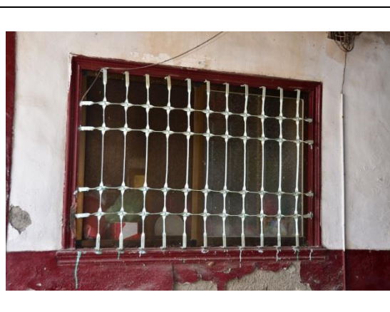
相5-2-26. 右橫屋窗戶改建為鋁窗，窗框仍維持原制，建議鋁窗拆除重新仿作，並將新制鐵柵欄拆，整體清潔後填補修復
