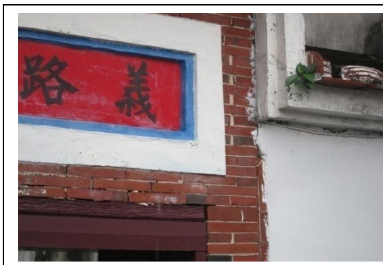
相4-1-155右騎馬廊入口門楣腐朽及補強與牆裂縫 相4-1-156右廊下旁間仔面牆裂縫至門角隅
