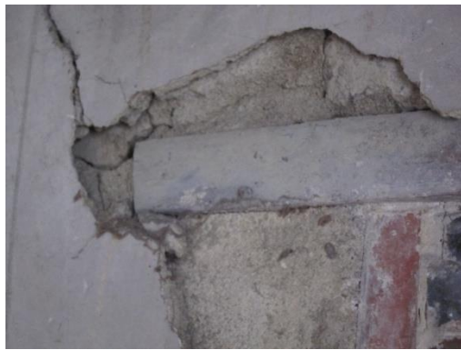
相4-1-45前堂右間仔隔間牆門楣角隅裂縫且表面材料剝落露出土埧
