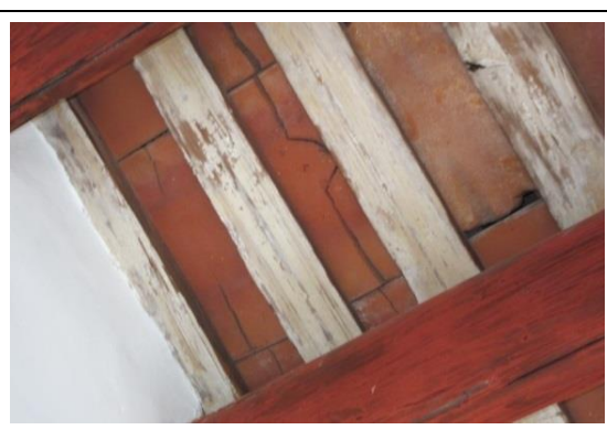
相5-2-2. 前堂門廳望磚破裂情形
