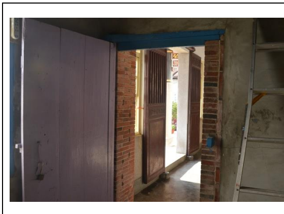
相5-2-19. 前堂左側正身間門扇表層抹以油漆維護，輕微受潮汙濁，清潔修補後可留用
