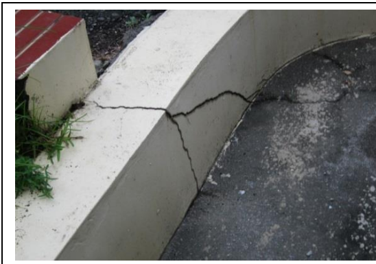
相4-1-93化胎左側邊牆裂縫
