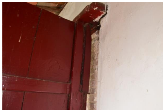
相5-2-22. 左側內門樓門板木料明顯乾縮劈裂，建議清潔後予以填補加固
