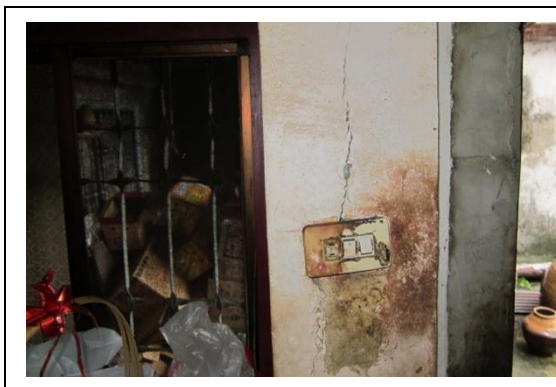
相4-1-157右廊下旁間仔面牆門窗間牆體裂縫 相4-1-158右橫屋西廳南側間仔隔間牆裂縫
