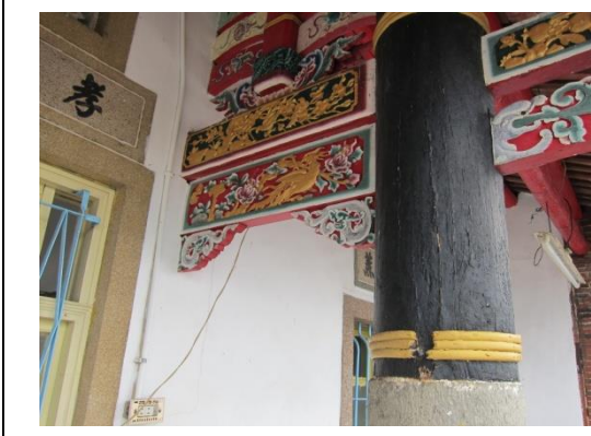
相4-1-51前堂檐廊左側廊柱漆繪裂及藤箍斷裂
