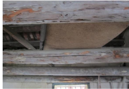
相4-1-22前堂右間仔夾層桁木沿構材方向裂縫
