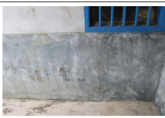
相4-1-136左橫屋臨騎馬廊面牆油漆剝落
