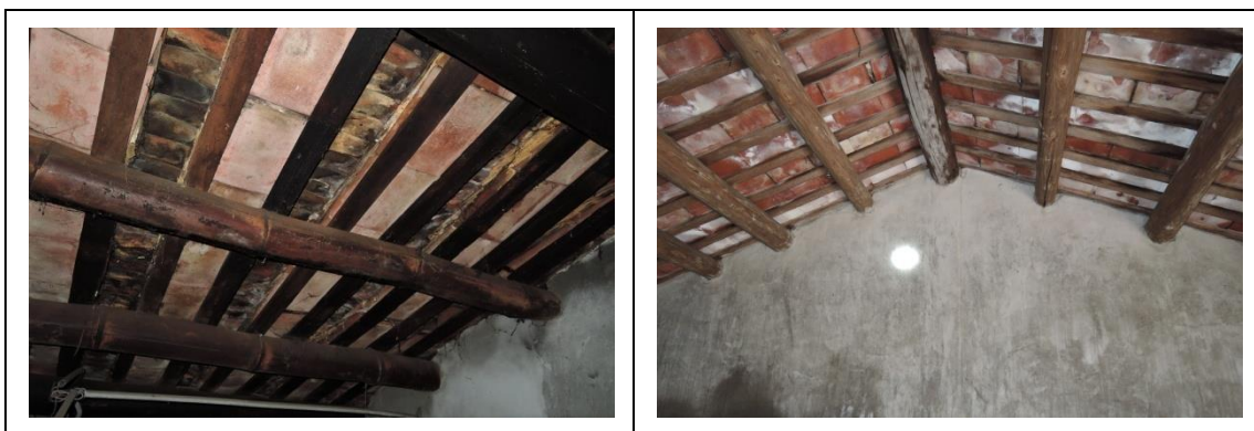
相4-1-147右橫屋臨禾埕間仔使用竹檁 相4-1-148右橫屋西廳南側間仔檁沿構材方向裂縫
