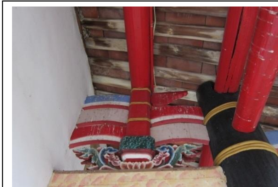
相4-1-11前堂檐廊右間仔前檁沿構材方向裂縫 及屋架水痕
