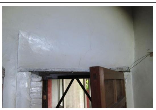
相4-1-109左橫屋東廳右側間仔面牆窗戶上緣牆 相4-1-110左橫屋東廳右側間仔門上緣牆垂直裂 垂直裂縫 縫
