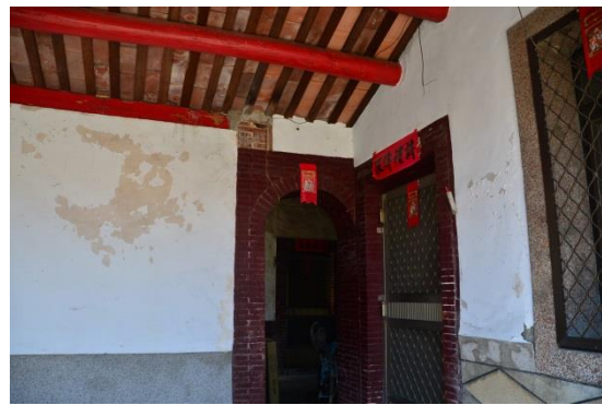
相5-2-11. 左廊牆面粉刷層些微浮凸剝落，可予以清潔後保留原貌
