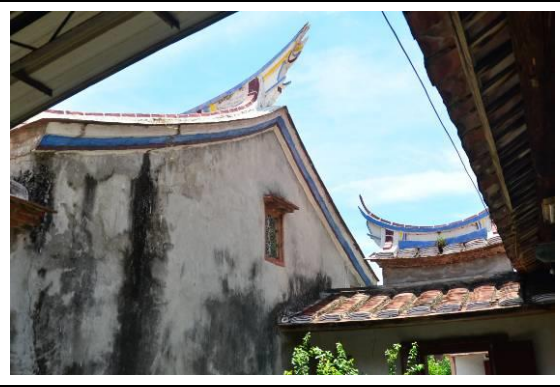
相3-3-16 前堂右側山牆面，白灰表面粉刷面層受潮汗濁、生苔、且局部粉刷層浮凸剝落
