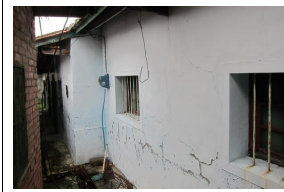
相4-1-117左橫屋背牆出簷斗拱處垂直裂縫及漆塗剝落
