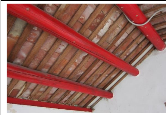
相4-1-59左廊望磚破裂修補
