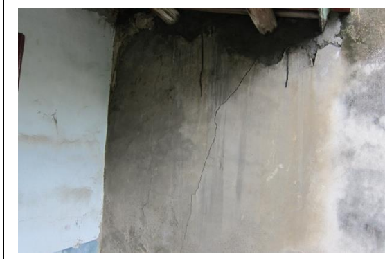
相4-1-125左騎馬廊入口櫟下山牆垂直裂縫
