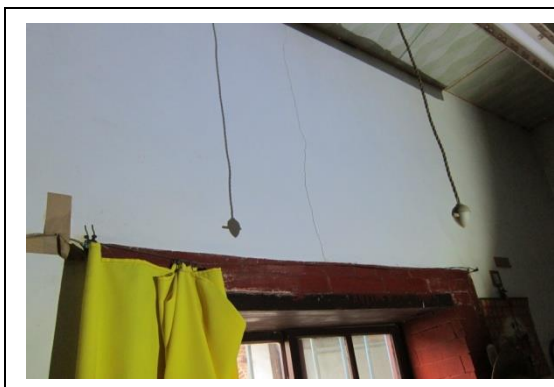
相4-1-109左橫屋東廳右側間仔面牆窗戶上緣牆 相4-1-110左橫屋東廳右側間仔門上緣牆垂直裂 垂直裂縫 縫
