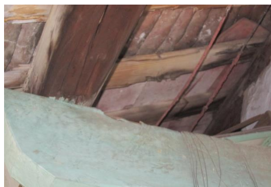
相4-1-98左橫屋面牆出簷檁沿構材方向裂縫
