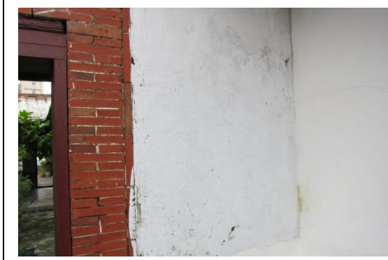
相4-1-123左騎馬廊入口左側牆體裂縫
