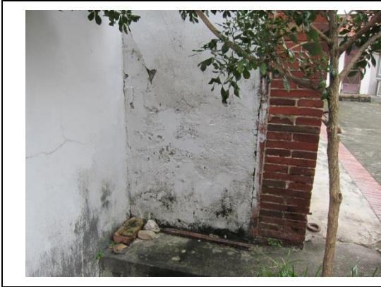
相4-1-49前堂右山牆外側表面裝修材料浮凸
