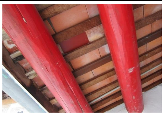
相4-1-58右廊檁沿構材方向裂縫及蟲蛀及望磚 破裂修補
