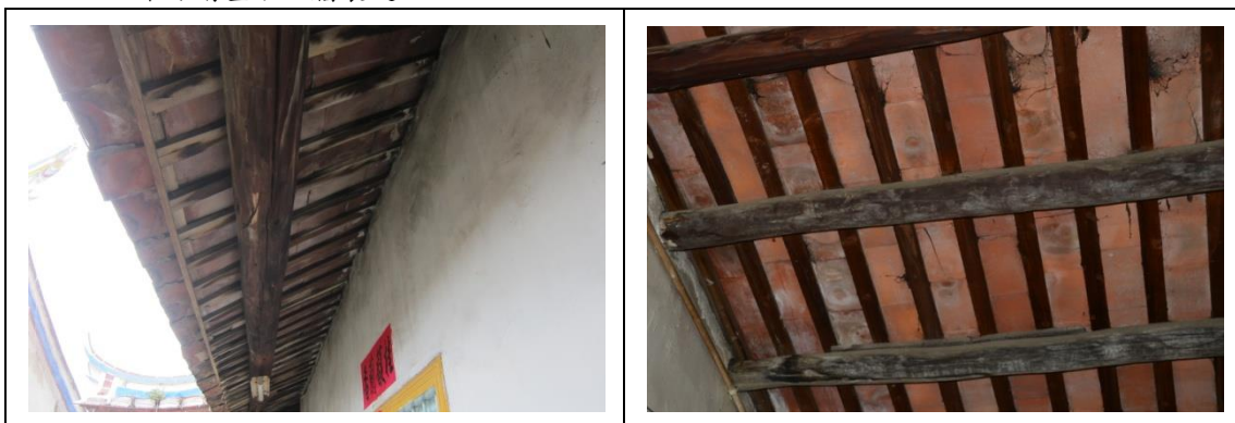
相4-1-145右橫屋面牆簷廊檁沿構材方向裂縫 相4-1-146右廊下檁構材變形修補
