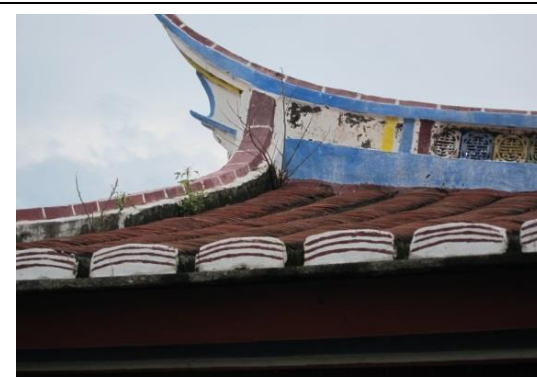
相4-1-26前堂屋頂右側規帶旁屋瓦植生破壞
