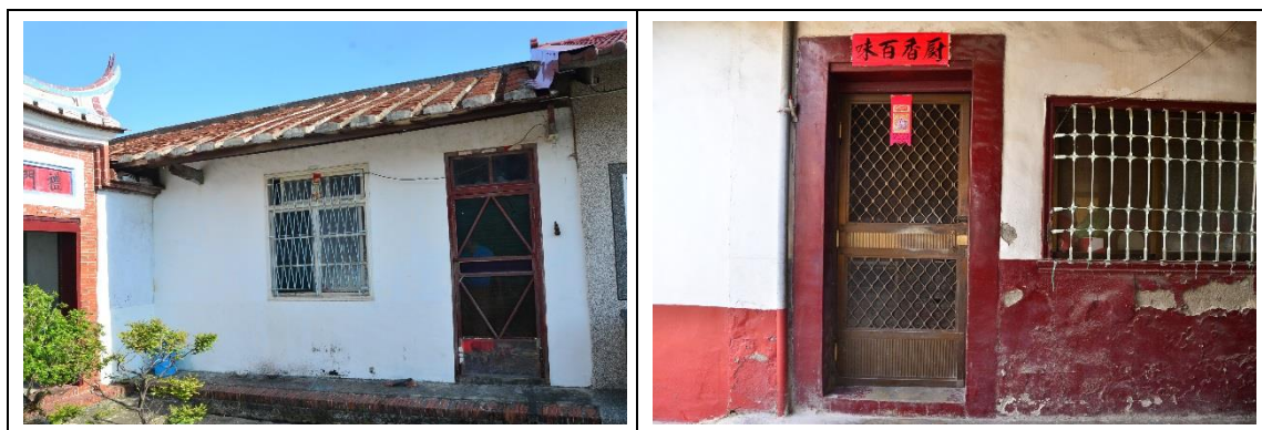
相3-3-101 W10、D13 保留原制，木料表層乾縮污濁些微脫漆 相3-3-102 D14、W14 改建為新式鋁製門窗，無原制遺構
