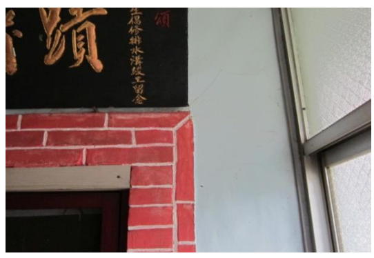
相4-1-126左橫屋東廳南側隔間牆開門角隅裂縫
