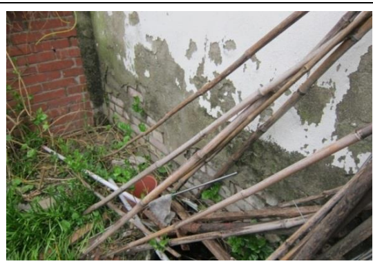
相4-1-4 門樓左側牆粉刷層剝落
