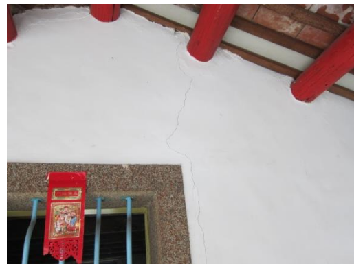
相4-1-40前堂背牆右間仔牆體支撐右廊檁處之延伸至窗開口角落裂縫 2
