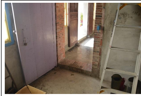
相3-3-45 D2-1 原制木作門扇，表層抹以油漆維護，輕微乾縮劈裂。
