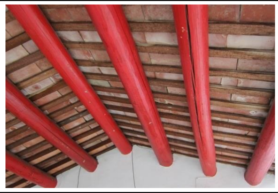
相5-2-4. 左廊標沿構材方向明顯裂縫
