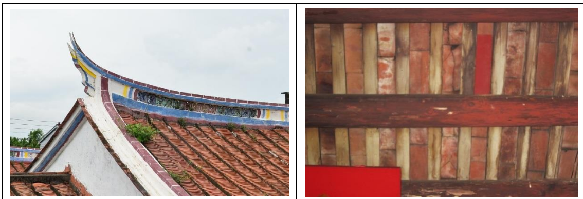
相4-1-73後堂左側屋脊裂縫及屋脊弧度呈現撓曲變形過大情形與屋面植生 相4-1-74後堂廳下望磚破裂修補
