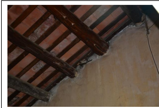
相4-1-153右廊下望磚裂及漏水痕跡
