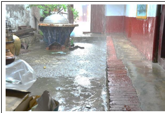
相3-2-47右側騎馬廊，雨水集中匯出排水孔
