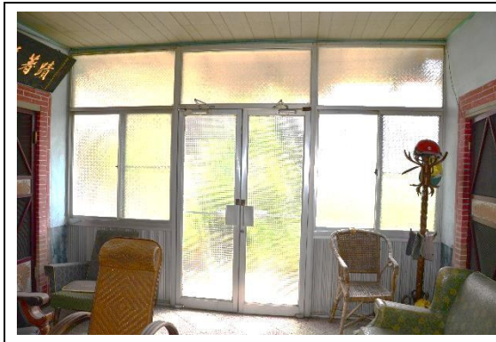
相3-3-83 東廳入口改為落地門窗，部分牆體遭拆除
