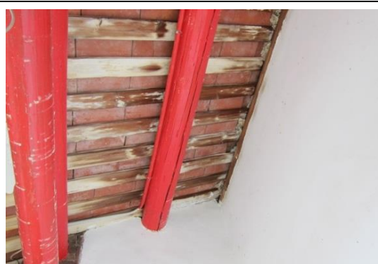
相4-1-12前堂檐廊右間仔前檁沿構材方向裂縫 及屋架水痕
