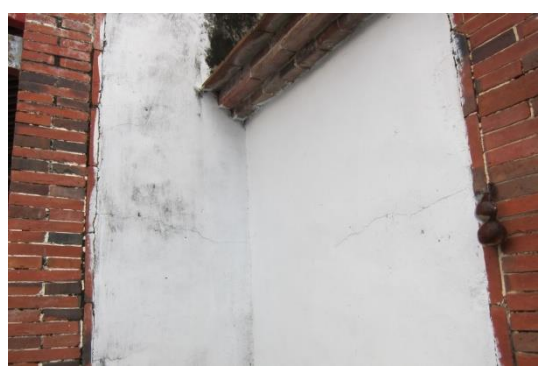
相4-1-124左騎馬廊入口右側牆體裂縫
