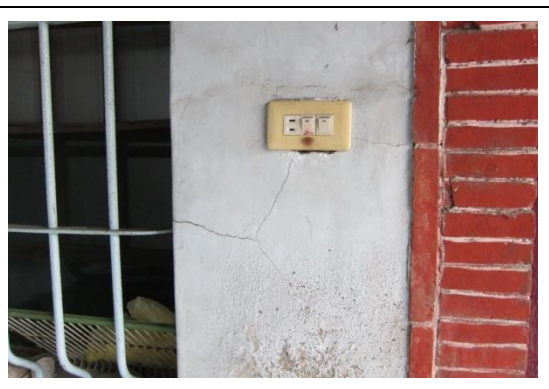
相4-1-111左橫屋廊下間仔裂縫由櫟下方裂縫至 相4-1-112左橫屋廊下間仔門與窗戶間裂縫 1 開門角隅
