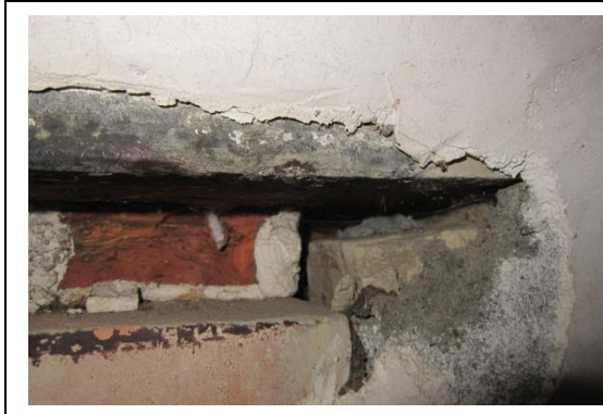
相4-1-137左橫屋東廳南側間仔牆表面材料剝落 土塊外露
