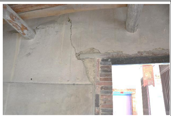
相3-3-12 右間仔牆面粉刷層龜裂浮凸，牆體結構外露
