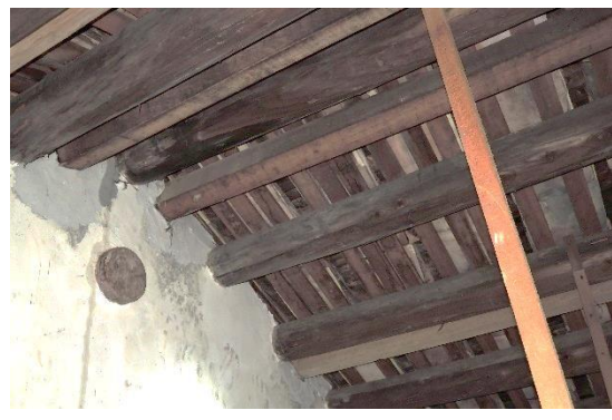
相3-3-89 桁木與牆面銜接處有受潮滲水現象
