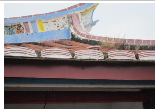
相4-1-25前堂屋頂左側規帶旁屋瓦植生破壞
