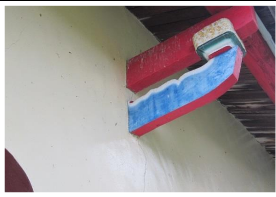
相4-1-78後堂廳下背牆右側出挑位置垂直方向 裂縫
