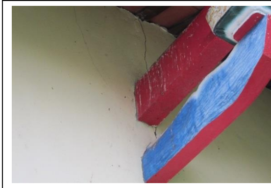
相4-1-77後堂廳下背牆左側出挑位置垂直方向 裂縫
