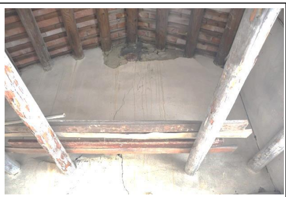
相3-3-14 牆面與屋架銜接觸龜裂破損，牆面受潮，表面粉刷層浮凸剝離嚴重
