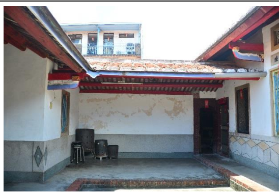
相3-2-42右側廊牆面粉刷層受潮浮凸剝落
