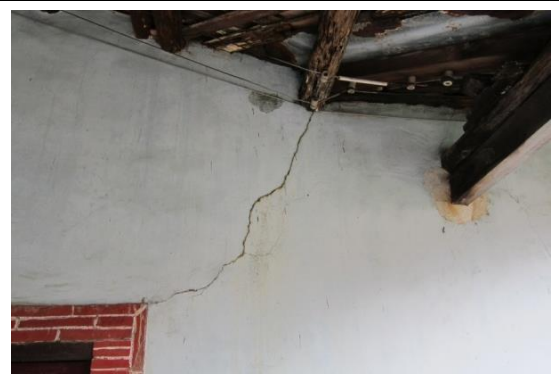
相5-2-6. 左橫屋廊下間仔裂縫由標下方裂縫至開門角隅
