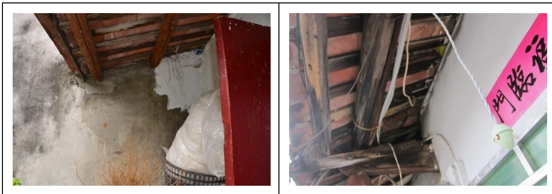
相4-1-143右騎馬廊入口檁沿構材方向裂縫及標 相4-1-144右橫屋臨禾埕檁沿構材方向裂縫 下方前堂右山牆裂縫
