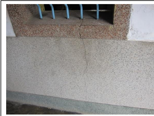
相4-1-37前堂背牆左間仔牆體開窗下緣垂直方向裂縫
