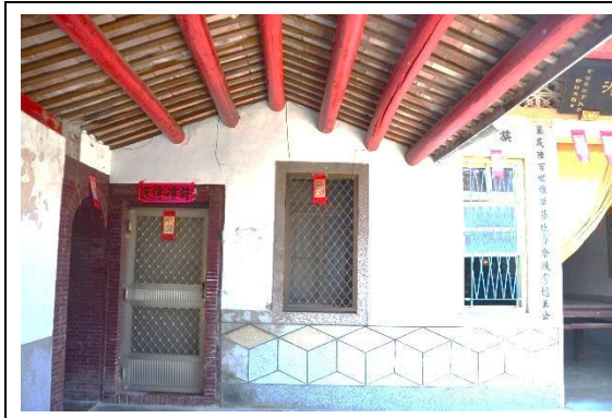
相3-3-53 左正身間正立面些微受潮汙濁，粉 刷層輕微脫落
