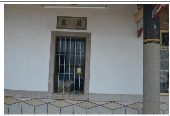
相3-3-48 W2-2 玻璃污濁破損，木料乾縮。
