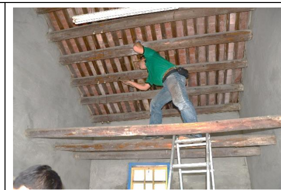
相3-3-26 大木匠師目測及敲擊木構件檢測損壞程度與因素
