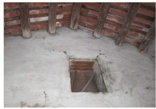
相4-1-20前堂左間仔上方檁裂及端部腐朽
