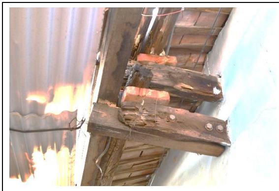
相3-3-93 第一戶背立面斗拱木構件做結構補強
