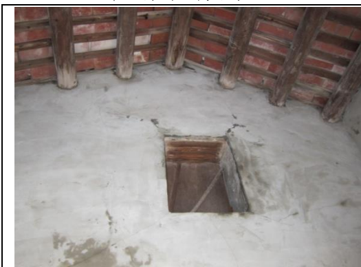
相4-1-41前堂左山牆有修補痕跡及通氣孔封閉處角隅裂縫
