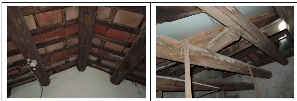
相4-1-105左廊下旁間仔望磚排列混亂及標沿構材方向裂縫 相4-1-106左廊下旁間仔屋頂傳條與屋瓦間鋪設情形
