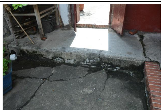
相3-2-48右側騎馬廊地坪龜裂破損嚴重
