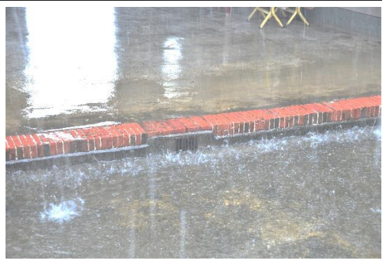
相3-2-40雨水自天井下方排水孔排出
