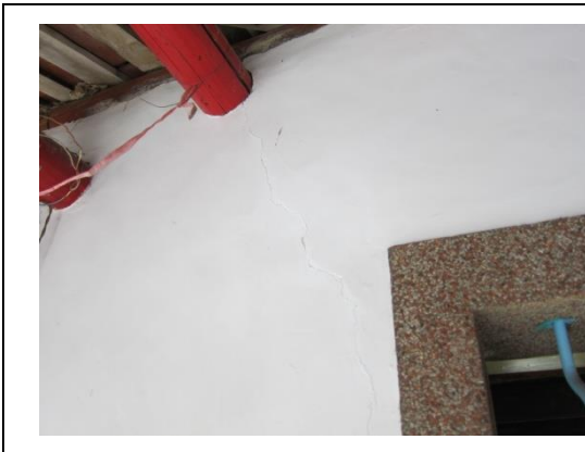
相4-1-39前堂背牆右間仔牆體支撐右廊檁處之延伸至窗開口角落裂縫 1
