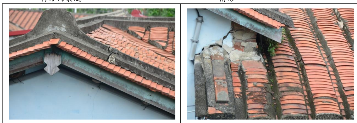
相4-1-107左橫屋南側屋頂規帶斷裂 相4-1-108左廊下屋頂出簷支撐不足而屋面變形
