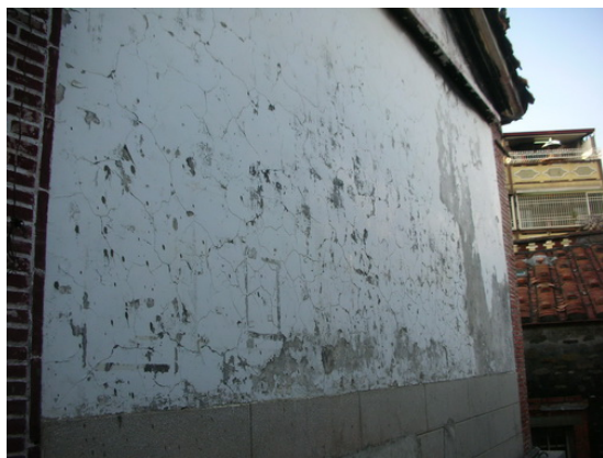
照片 5-11 正殿左側大歸壁龜裂痕跡
