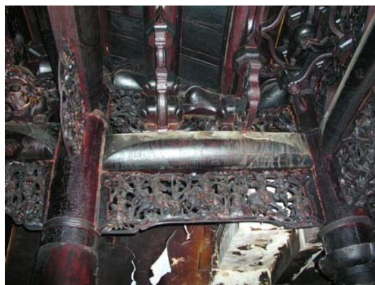
照片 3-38 前十一架楹下檐柱與拜亭金柱以通接續，通下置以通橢
