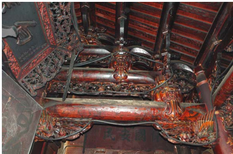
照片 3-117 台灣紅檜構築之步口木棟架 照片 3-118 台灣檜木構築之前殿木棟架
