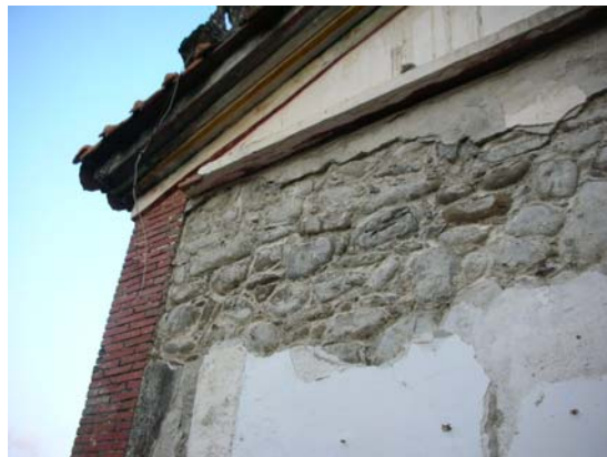
照片 4-3 山牆卵石組砌壁體損壞現況
