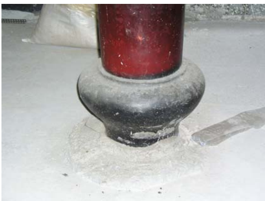
照片 3-58 正殿前點金柱及鼓形柱珠
