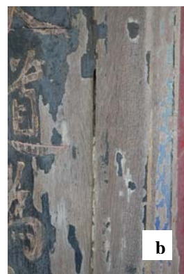
照片 5-46 前殿左前點金柱之風化外觀 a：木柱巨觀；b：微觀(台灣紅檜)
