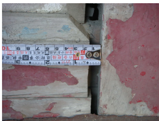
照片 5-4 門框與裙堵板開縫位移
