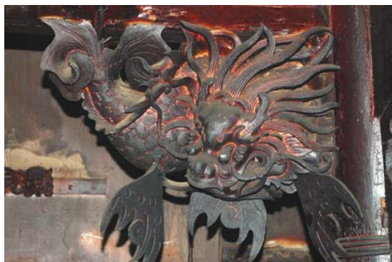
照片 5-51 受煙薰影響的正殿鰲魚構材 照片 5-52 受煙薰影響的拜亭獅座構材
