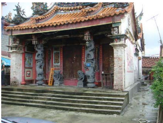
照片 5-23 前殿龍邊廊牆白灰剝落
