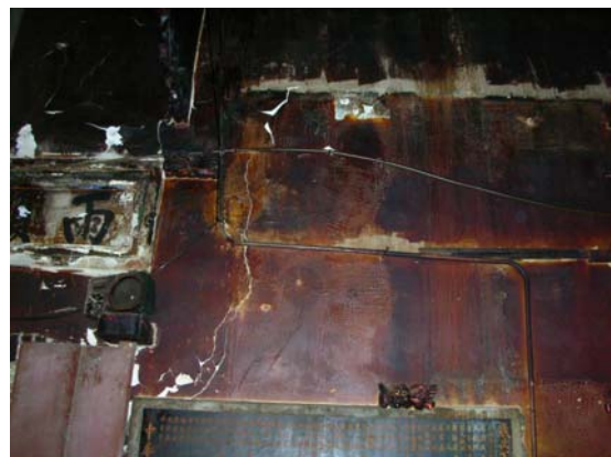
照片 5-10 巷頭門處有 45 度斜向裂痕
