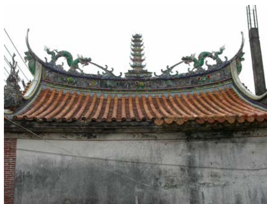
照片 3-50 正殿後牆三合土粉刷
