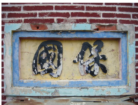
照片 5-13 門頭堵出磚遷廟鑽孔破壞
