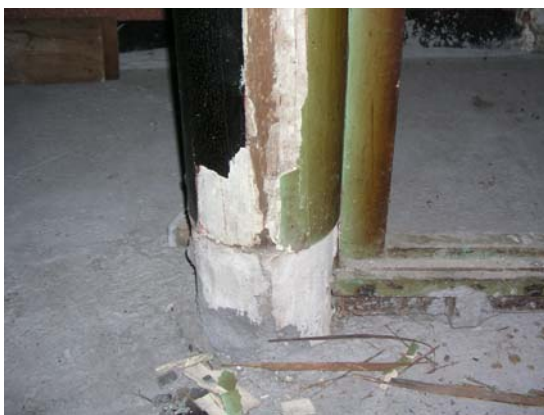
照片 3-59 正殿後點金柱及圓直筒形柱珠
