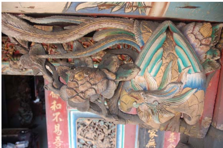
照片 3-119 前殿明間之樟木插角構材 照片 3-120 前殿明間之樟木裙板構材
