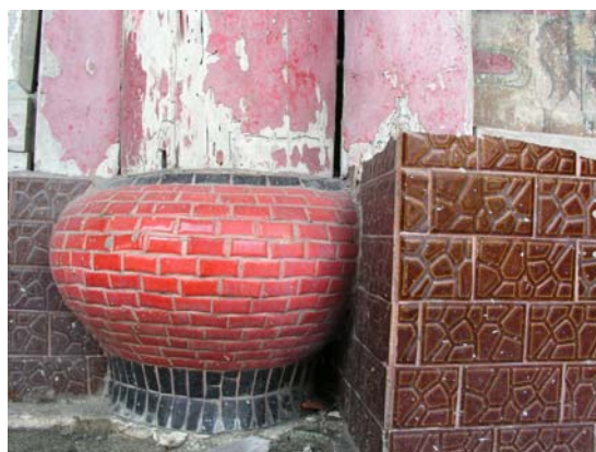
照片 3-54 前殿排樓面封柱柱珠
