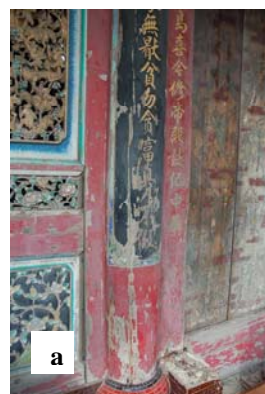
照片 5-46 前殿左前點金柱之風化外觀 a：木柱巨觀；b：微觀(台灣紅檜)
