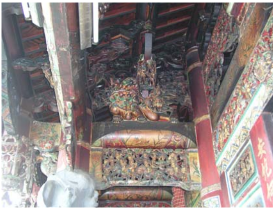
照片 3-25 前殿步口棟架
