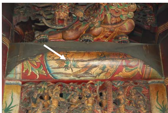
照片 5-49 前殿步口通之開裂現象 (台灣紅檜)
