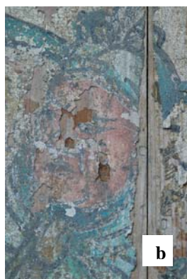
照片 5-47 前殿裙板之風化外觀 a：裙板巨觀；b：微觀(樟木)
