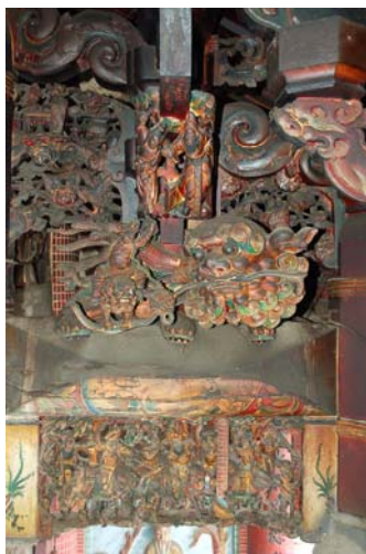
照片 3-117 台灣紅檜構築之步口木棟架 照片 3-118 台灣檜木構築之前殿木棟架
