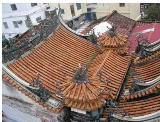
拜亭與前後殿接續處屋面漏水
