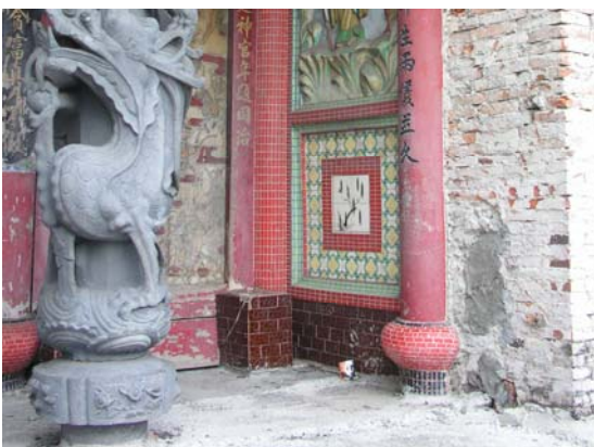
照片 3-60 前殿步口附壁柱及柱珠
