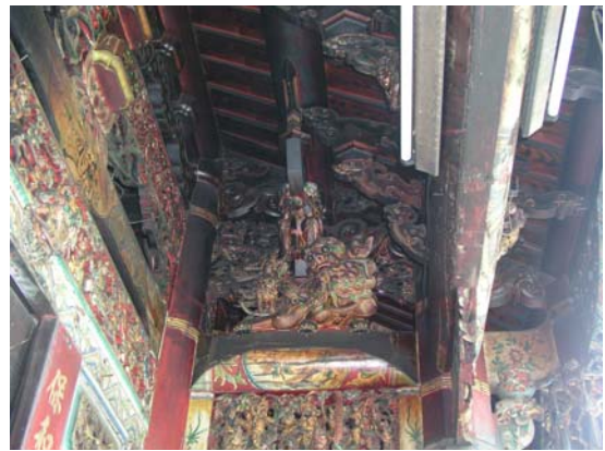
照片 3-25 前殿步口棟架
