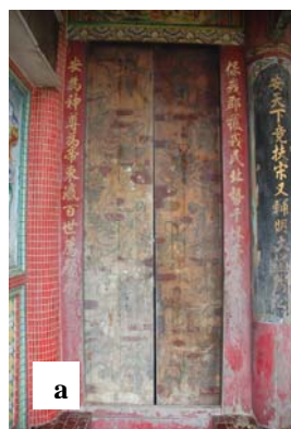
照片 5-47 前殿裙板之風化外觀 a：裙板巨觀；b：微觀(樟木)
