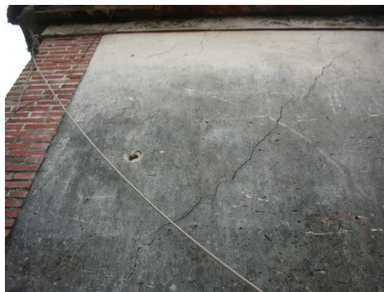
照片 5-12 正殿後檐牆斜向龜裂
