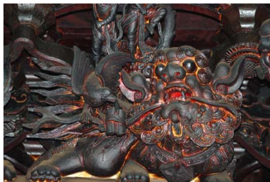
照片 5-51 受煙薰影響的正殿鰲魚構材 照片 5-52 受煙薰影響的拜亭獅座構材
