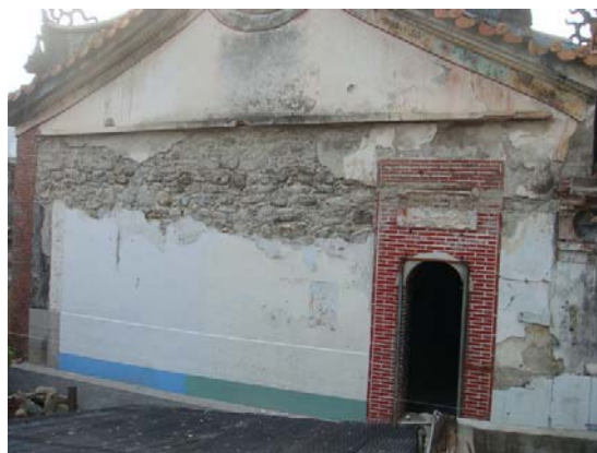
照片 5-24 虎邊山牆鳥踏下方白灰剝落
