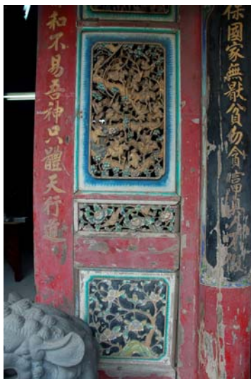
照片 3-115 前殿明間之台灣紅檜金柱、門框構材
