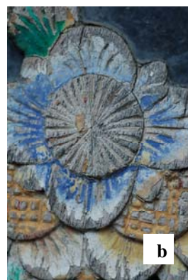
照片 5-48 前殿左次間門板之風化外觀 觀 a：裙板巨觀；b：微觀(台灣紅檜)
