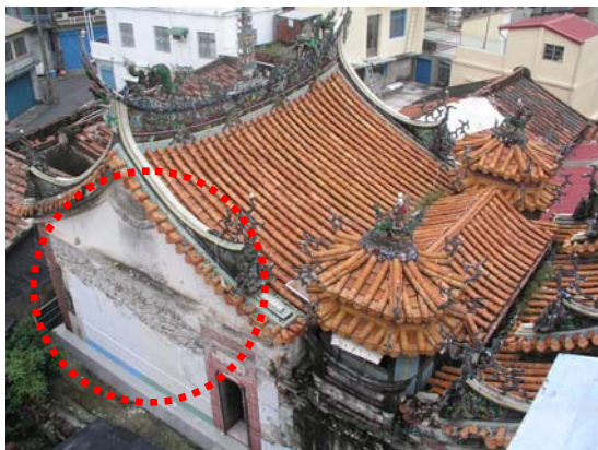
照片 4-3 山牆卵石組砌壁體損壞現況
