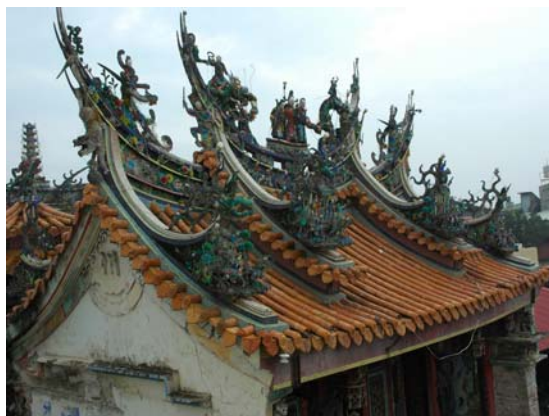
屋面剪黏破損脫落
