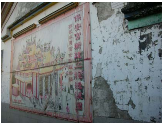
照片 5-9 45 度方向的龜裂
