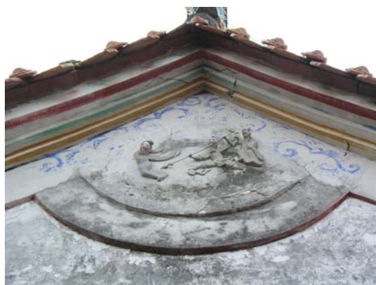
照片 4-5 壁面白灰粉刷損壞現況
