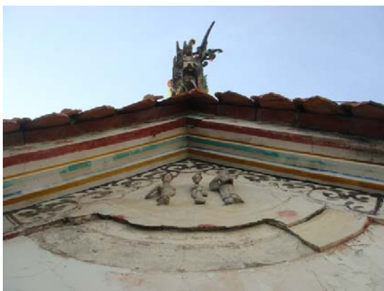
照片 5-25 脊墜泥塑剝落
