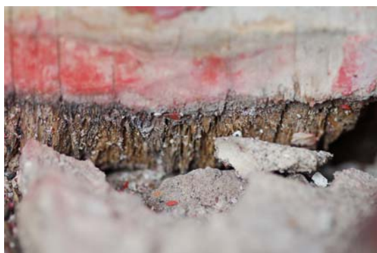
照片 5-43 前殿左次間門框底部之腐朽侵害
