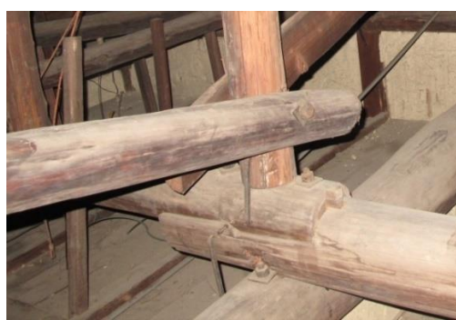
照片 3-27 勝利路 135 號屋架大樑樑接 構造(小屋台持繼)
