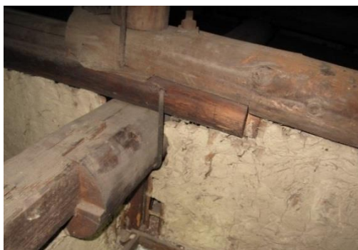
照片 3-26 勝利路 135 號大樑接合處以 螞蝗釘固定
