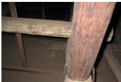
照片 3-30 天井板材（杉木板）置入木格柵框內
