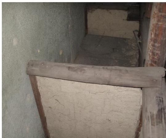
照片3- 14 永勝巷3號天井板上方的編竹夾泥牆未塗白灰
