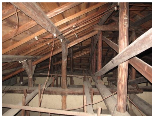
照片 3-32 吊木釘在吊筋樑兩側
