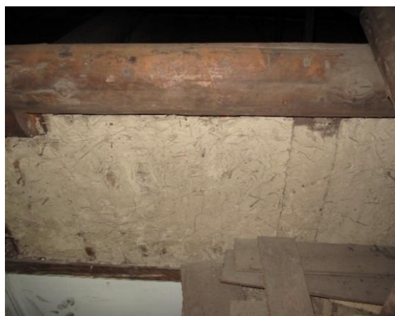
照片3- 15 勝利路135號隔間牆上方的立柱塗抹土漿
