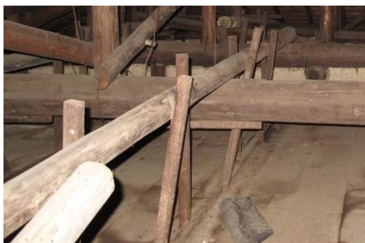
照片 3-29 方木吊筋藉由上下固定懸吊天花板
