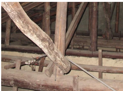
照片 3-31 吊木釘在橫向的吊筋樑或大樑
