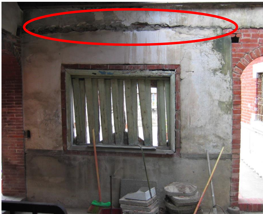
照片 4-14 牆體背部上面有一明顯水平裂縫
