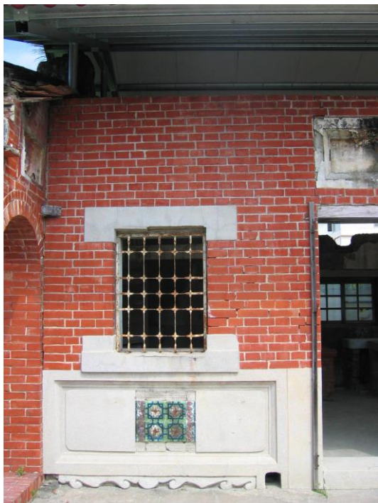
照片 4-28 牆體發生灰縫剝落
