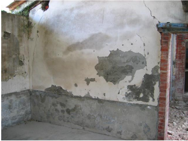
照片 4-49 牆體外飾材發生剝落
