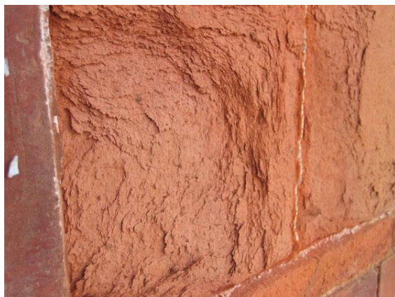
照片 4-10 斗砌牆外飾材長時間受到風化
