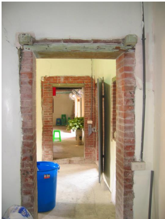
照片 4-61 開口部發生斜向裂縫
