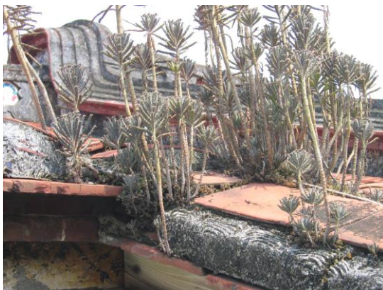
照片 4-59 屋頂有植物生長，長期可能導致漏水
