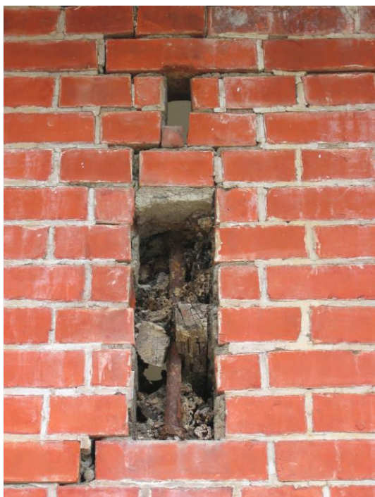
照片 4-30 牆體原本應有軟挑的拱，且利用鐵件補強，並有斜向裂縫通過。
