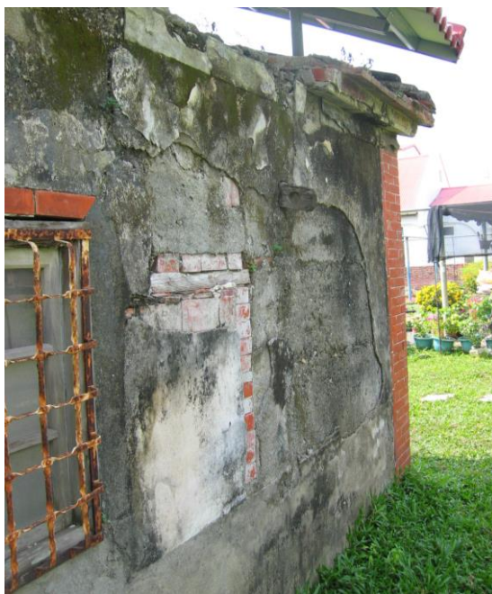
照片 4-38 右護龍背牆外飾材發生破壞
