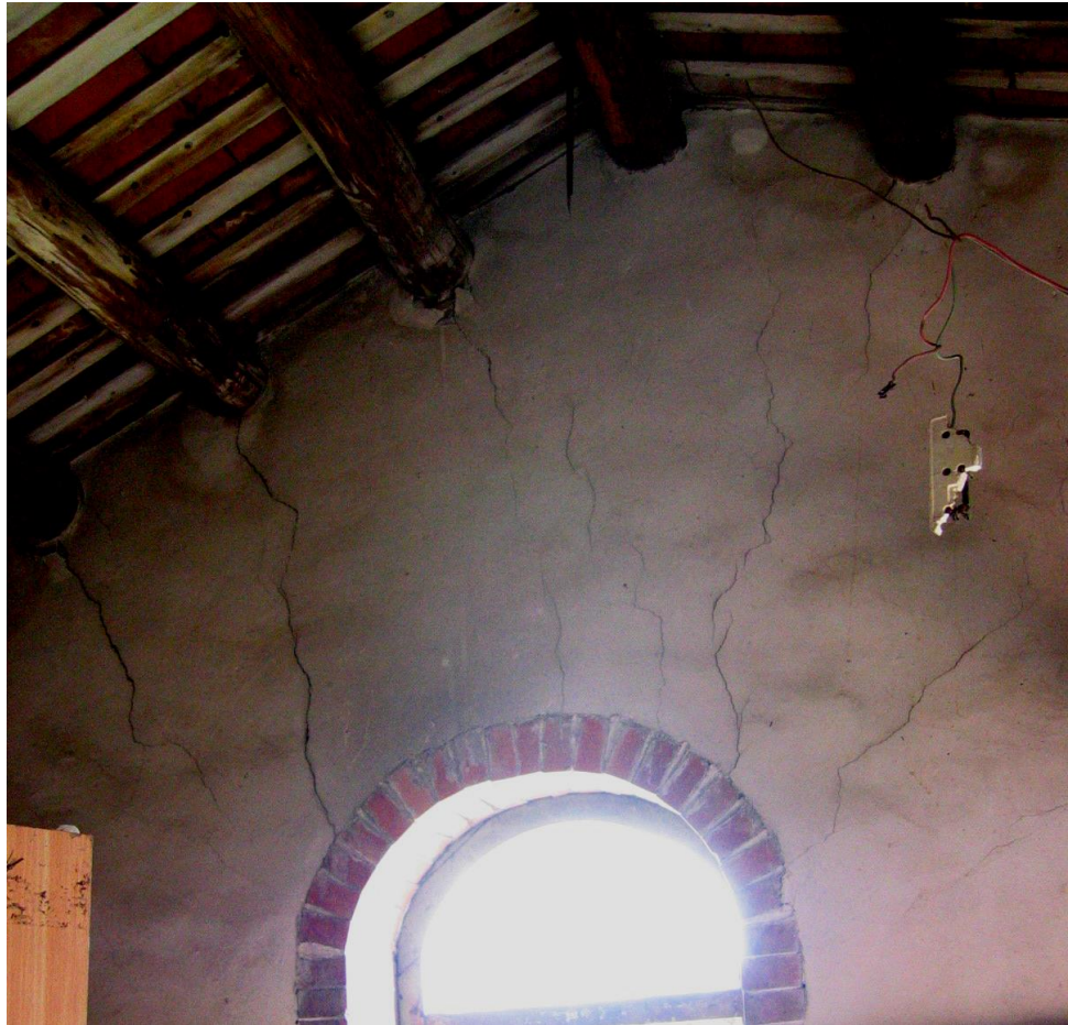
照片 4-46 拱窗上部發生許多斜向裂縫
