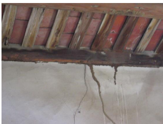
照片 4-45 桁條與牆體交界處有明顯的蟻路
