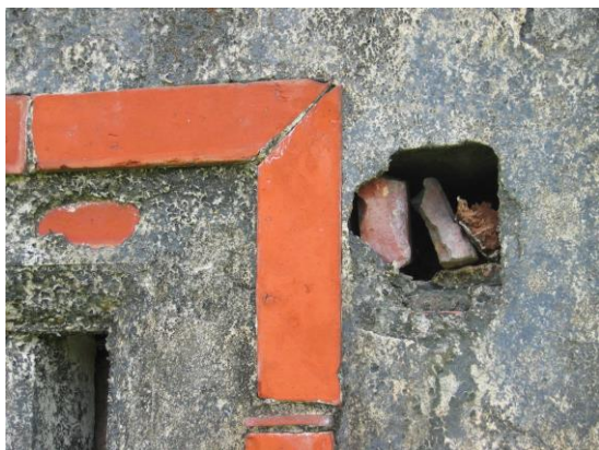
照片 4-39 右護龍背牆窗戶周圍外飾材破壞，內填充物外露
