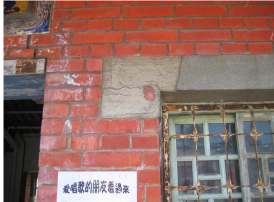
照片 4-56 牆體開口部發生外飾材剝落
