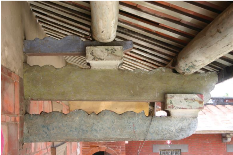
照片 1-12 正身步口出挑 RC 構件
