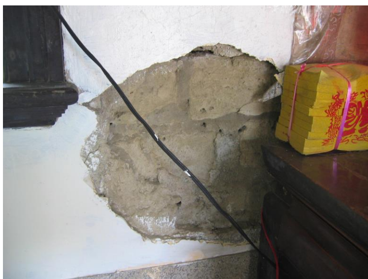
照片 4-24 背牆內部外飾材剝落，土塊外露
