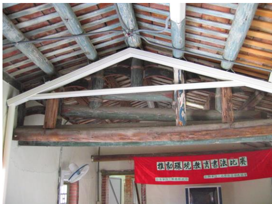
照片 4-65 木構架水平大樑發生嚴重下垂並利用鋼架做暫時支撐
