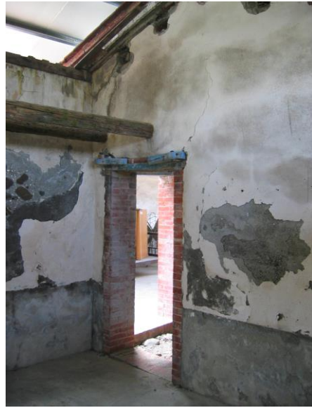
照片 4-50 牆體開口部發生斜向裂縫
