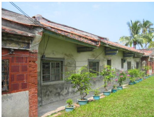
照片 4-5 正廳背牆為土埆造並直接抹白灰
