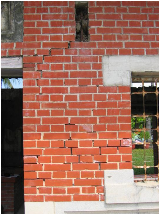
照片 4-31 牆體發生灰縫剝落且開口部發生斜向裂縫
