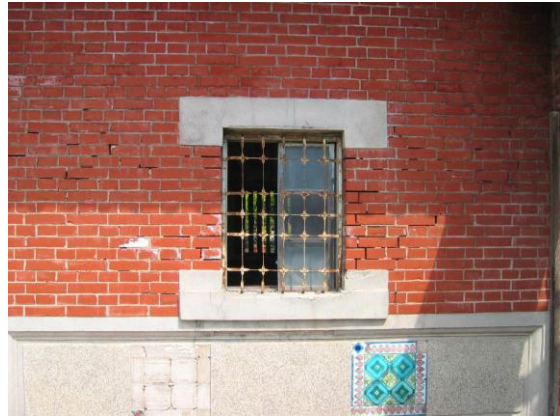
照片 4-33 牆體發生灰縫剝落且開口部發生斜向裂縫
