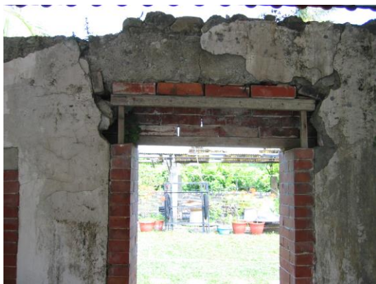
照片 4-41 右護龍門開口部破壞
