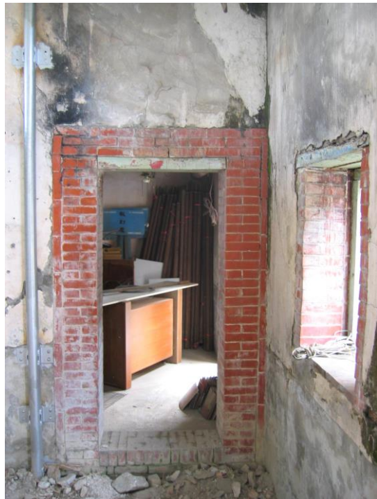
照片 4-48 牆體開口部發生斜向裂縫
