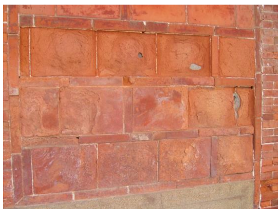
照片 4-20 磚材大片面積風化
