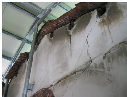
照片 4-54 牆體開口部發生斜向裂縫
