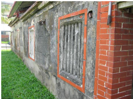
照片 4-37 右護龍背牆有許多外飾材發生破壞
