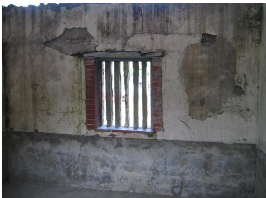
照片 4-43 右護龍窗戶周圍外飾材破壞並發生裂縫
