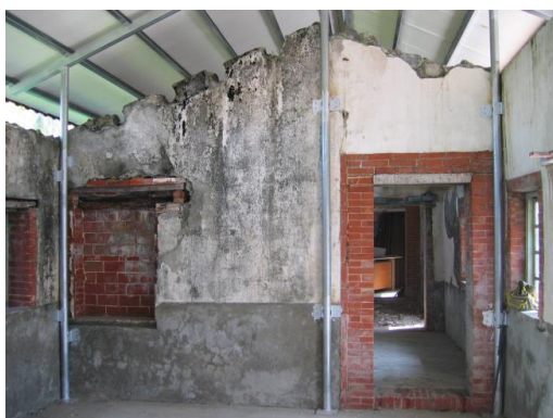
照片 4-3 開口部上方利用木製衡量承重
