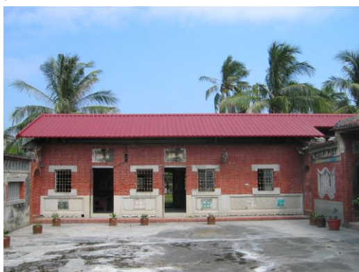
照片 4-1 左右護龍為磚構造
