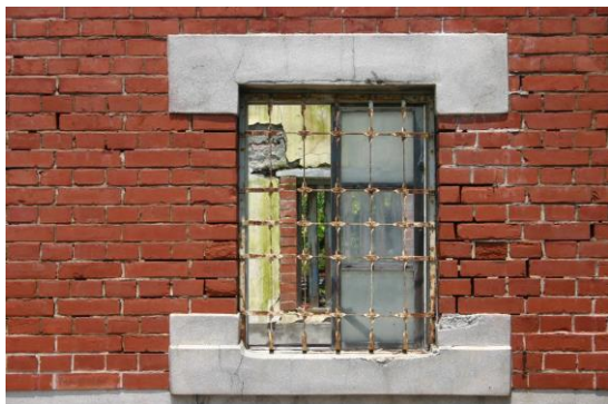
照片 3-14 窗台上下仿石造構件(受日治時期洋樓建築影響)
