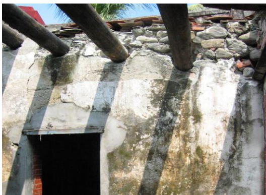
照片 4-36 灰縫剝落內部填充材外露
