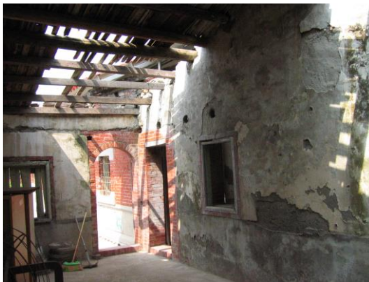
照片 4-34 牆體發生灰縫剝落且桁條破壞導致屋瓦掉落
