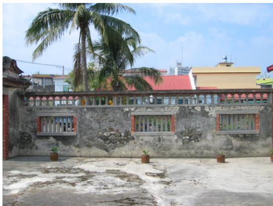
照片 4-67 圍牆背部灰漿掉落且卵石外露
