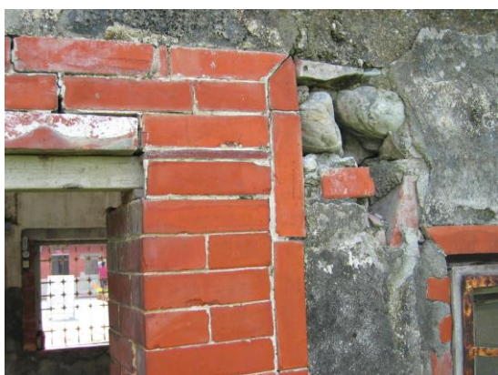
照片 4-40 門框周遭外飾材破壞，填充物外露
