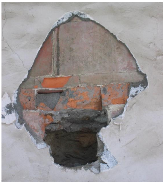
照片 4-17 灰縫剝落後斗子砌牆體路出
