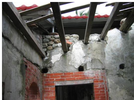
照片 4-35 灰縫剝落內部填充材外露
