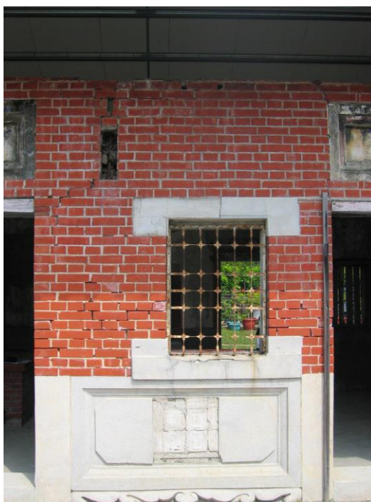
照片 4-29 牆體發生灰縫剝落且開口部發生斜向裂縫
