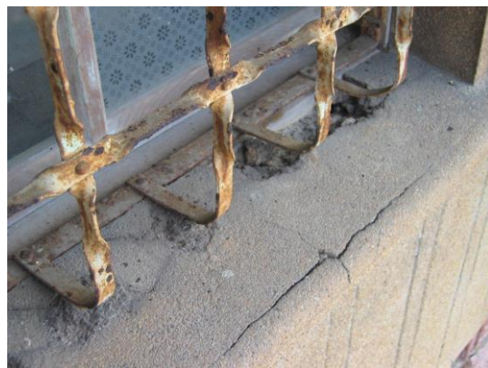
照片 4-23 窗台粉刷層發生裂縫
