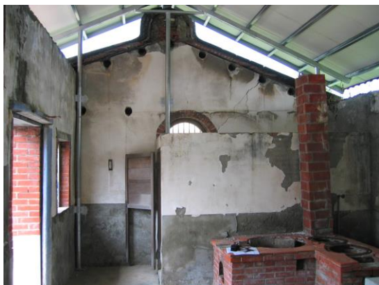
照片 4-53 牆體發生斜向裂縫
