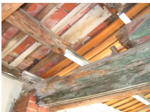
照片 4-9 抬梁式屋架架在磚柱上
