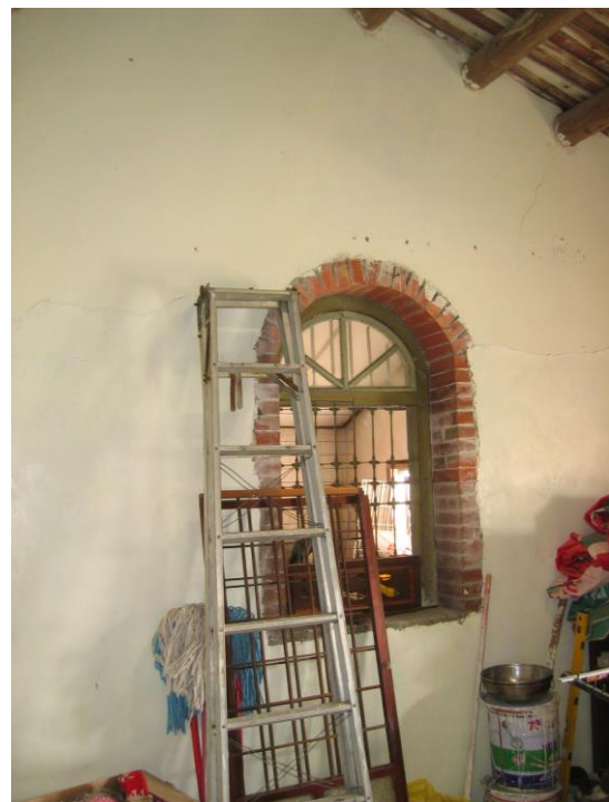
照片 4-60 牆體開口部發生斜向裂縫
