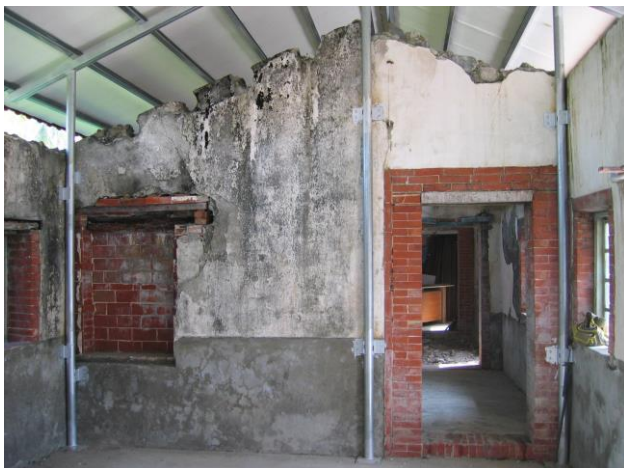
照片 4-51 牆體外飾材發生剝落及開口部破壞
