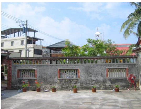
照片 4-68 圍牆背部灰漿掉落且卵石外露
