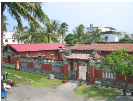
照片 4-6 門屋及圍牆正立面為磚構造
