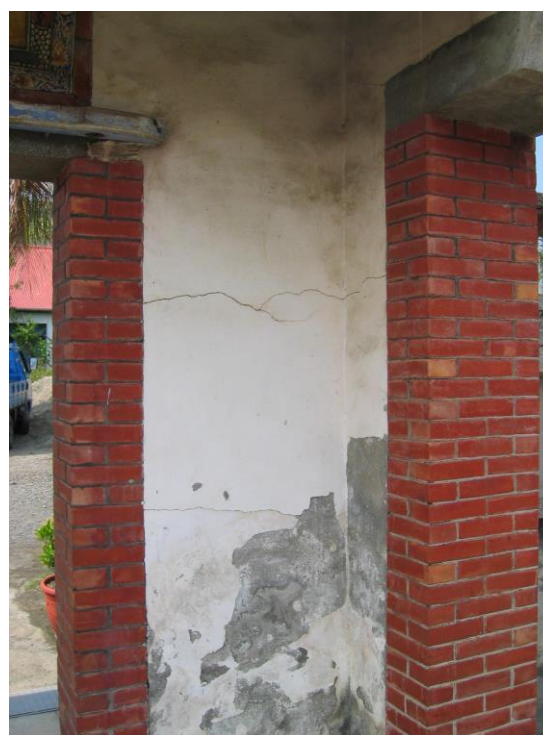
照片 4-70 門屋發生水平裂縫及油漆剝落
