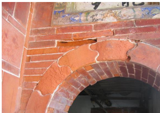
照片 4-25 拱門上方磚材發生風化
