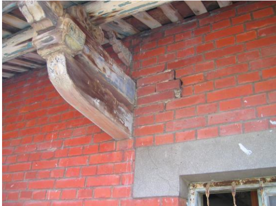
照片 4-55 牆體磚材發生裂縫
