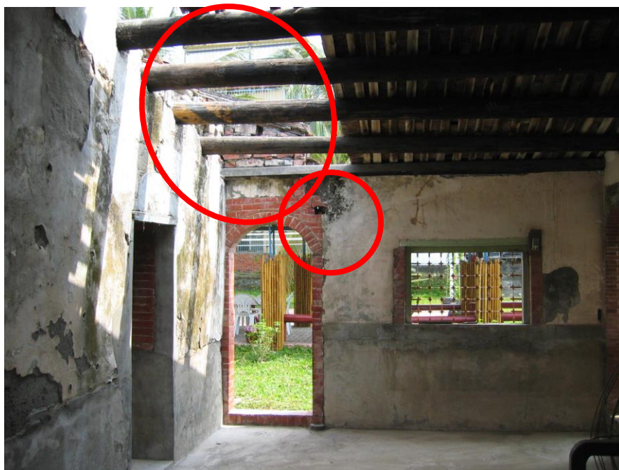
照片 4-15 屋頂塌陷且門上方有水漬的痕跡
