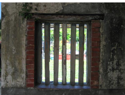
照片 4-2 開口部上方利用木製衡量支承重量
