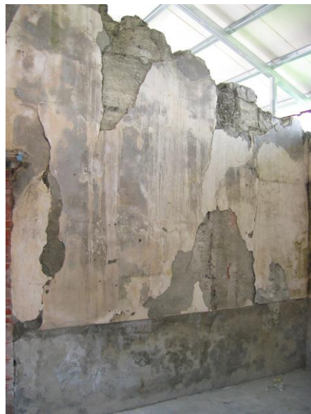
照片 4-52 牆體外飾材剝落磚材外露
