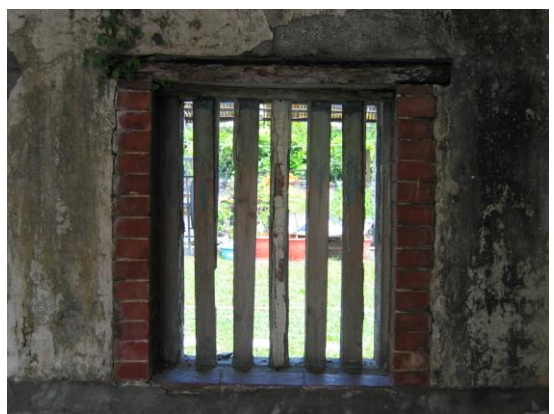
照片 4-42 右護龍窗開口部破壞
