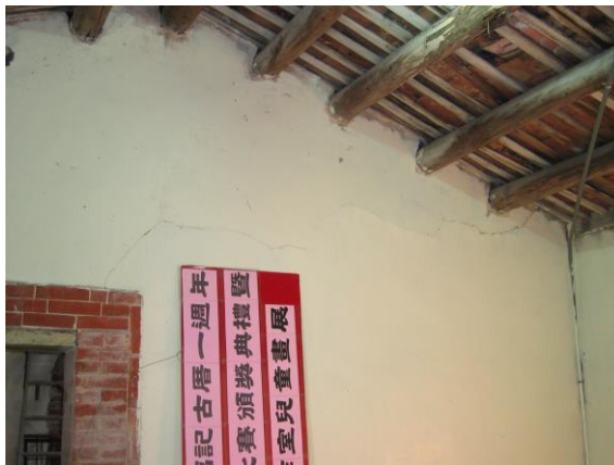
照片 4-62 牆體開口部發生斜向裂縫
