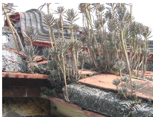
照片 4-11 植物生長在建築物屋頂導致屋頂 漏水
