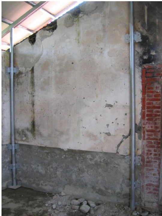
照片 4-47 牆體外飾材發生剝落
