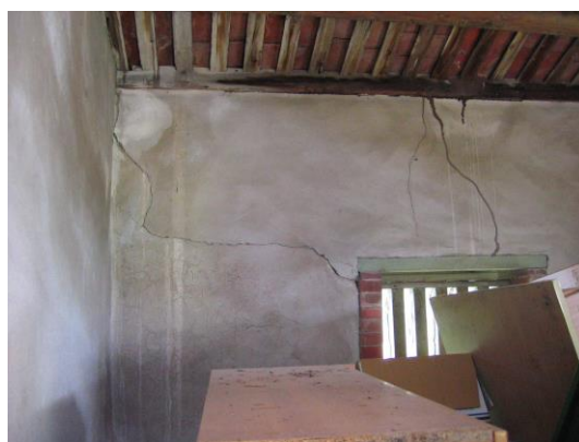
照片 4-44 窗戶開口部發生斜向裂縫
