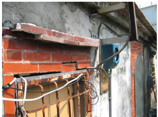
照片 4-58 窗框發生磚材破壞
