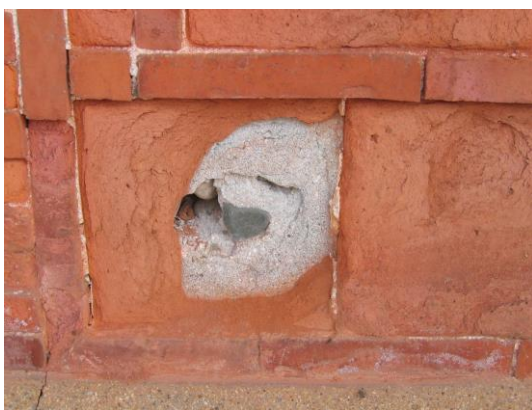
照片 4-19 磚材風化嚴重後內部填充材外露
