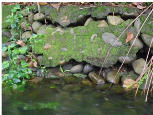
▲長期地下水由護岸內填縫滲水湧出，造成工程劣化的情況
