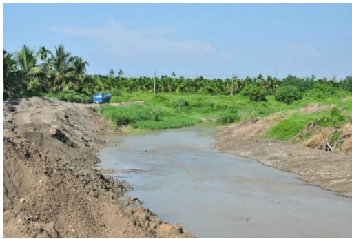
▲新赤農場排水工程大面積開挖河道情形
