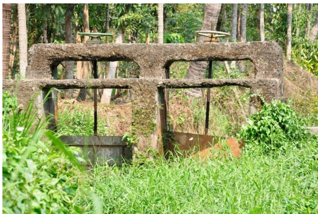
▲一號水門常年失修損壞，兩側農地沖刷流失
