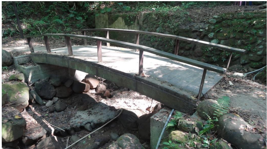
▲跨河步道橋設計範例，以鋼筋為結構，輔以石板底和木椿圍籬
