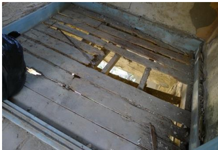
照片 3.3. 27 R2F-3 儲藏室空間鋪 面地板破損佚失，木格柵遭腐朽 蛀蝕
