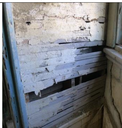
照片 3.3. 97 R1F-7 板條灰泥牆的 粉刷面層剝落嚴重
