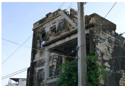
照片 3.3.43 洋樓東向建築外牆在空心磚的表面水泥砂漿粉刷層呈現水漬
