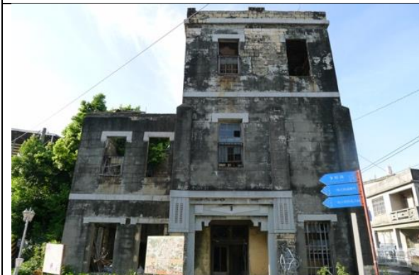
照片 3.3. 55 洋樓正向立面因灰塵與水的作用下呈現灰黑色樣貌
