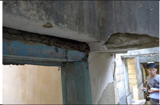
照片 3.3. 82 R1F-4 本空間牆面粉刷層破損與脫落，
