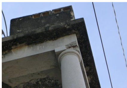
照片 3.3.50 羅馬塔司干柱式頂部有破損
