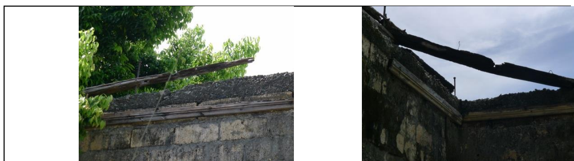
照片 3.3. 155 空心磚牆頂方殘餘木構件及固定木構的鐵件。
