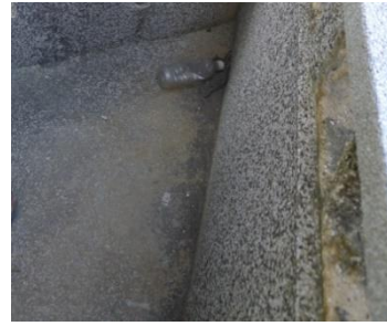
照片 3.3. 34 R2F-5 二樓露台為磨石子地坪，有風化現象。
