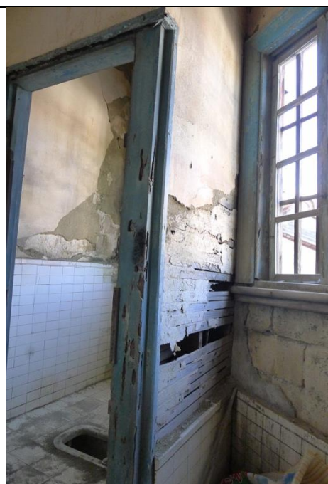
照片 3.3. 98 R1F-7 板條灰泥牆 的粉刷面層剝落嚴重
