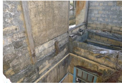
照片 3.3. 26 R2F-2 和式架高， 木構架地板與鋼筋混凝土梁有一高差。
