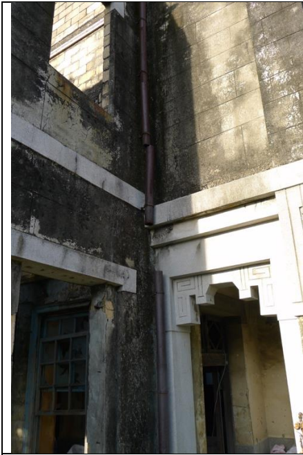
照片 3.3. 53 洗石子的裝修面較不受水與灰塵的污染，可呈現原來之色澤
