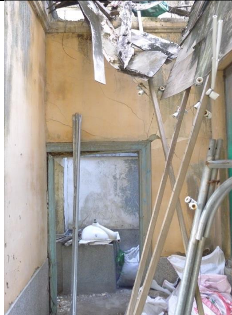
照片 3.3. 86 R1F-5 走廊的公共空間，牆面灰泥粉刷層北側受損較少
