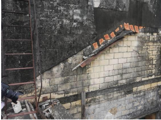
照片 4.2. 9 木構寄棟屋架佚失，僅存 屋面與牆體介面泛水遺構
