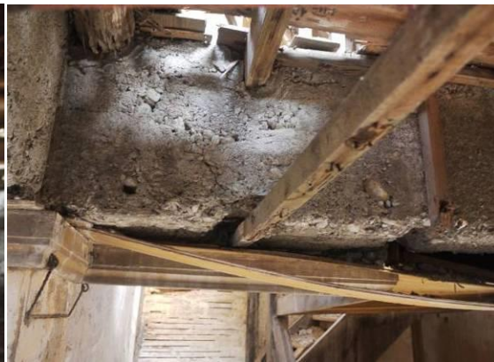
照片 4.2.6 入口門廳 RC 樑混凝土狀 況不佳
