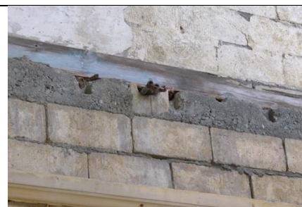
照片 3.3. 36 R3F-1 鋼筋混凝土梁留有與木構件接合之榫口
