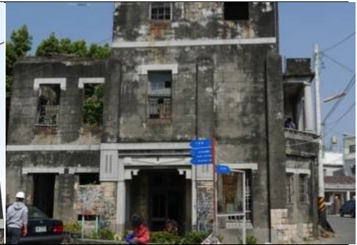
照片 3.2.9 洋樓 3 樓外牆有加扶壁柱
