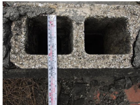
照片 4.1.8 內部短向開孔寬約 10cm、 面殼厚度約 3.5cm
