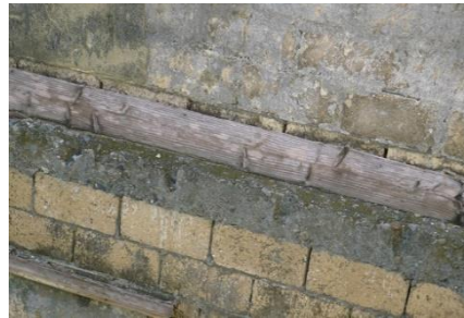
照片 3.3. 22 R2F-1 鋼筋混凝土圈梁上有遺留木構件
