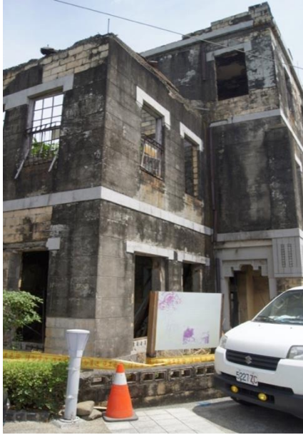
照片 3.2.6 粉刷層覆蓋原空心磚表面層(2015/07/16 拍攝)
