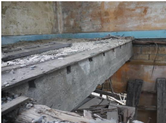
照片 4.2. 13 二樓木樓板構造佚失，可 見 RC 樑上之根太(樓板格柵樑)嵌合 孔
