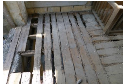
照片 3.3. 28 R2F-4 鋪面地板已 有破損佚失，木格柵遭腐朽蛀 蝕
