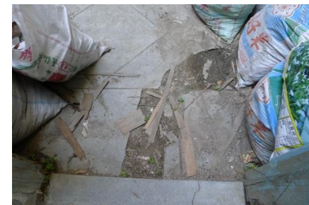
照片 3.3. 12 R1F-6 臥室空間磨石子地坪在入口有明顯的破損剝落
