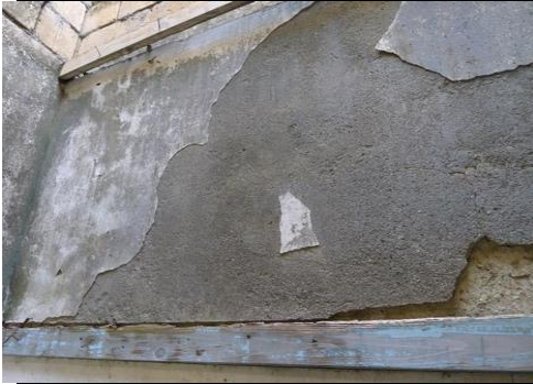
照片 3.3. 81 R1F-4 本空間牆面粉刷層破損與脫落，
