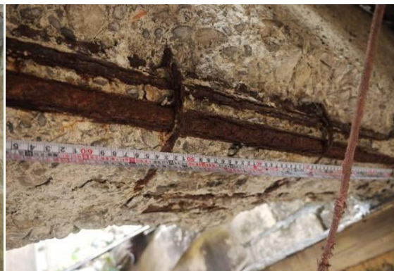
照片 4.2. 2 二樓露台內側 RC 樑鋼筋銹蝕、保護層剝落
