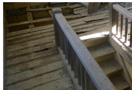
照片 3.3. 32 R2F-4 樓梯上二樓 鋪面木地板破損情形
