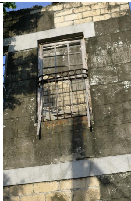
照片 3.3. 52 建築物西側黑色水漬的污染，裸露的空心磚表面所受水漬污染較少
