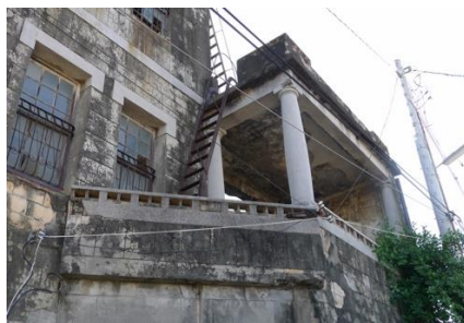
照片 3.3.44 洋樓表層露出原來略呈黃色的空心磚牆表面
