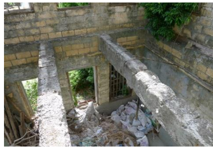
照片 3.3. 20 R2F-1 二樓臥室樓板已經佚失，只剩留鋼筋混凝土梁。
