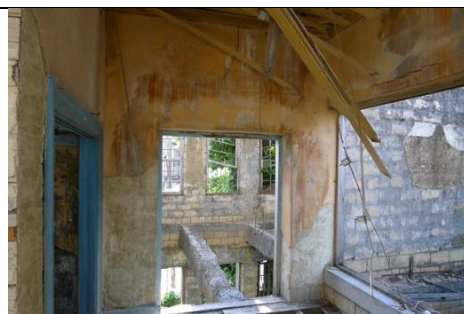
照片 3.2.41 二樓左右橫拉的方式開啟，門框留有凹槽軌道
