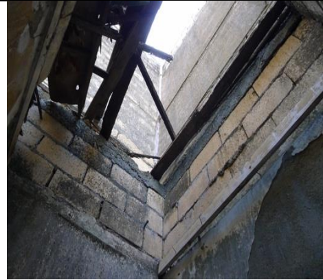
照片 3.3. 82 R1F-4 本空間牆面粉刷層破損與脫落，
