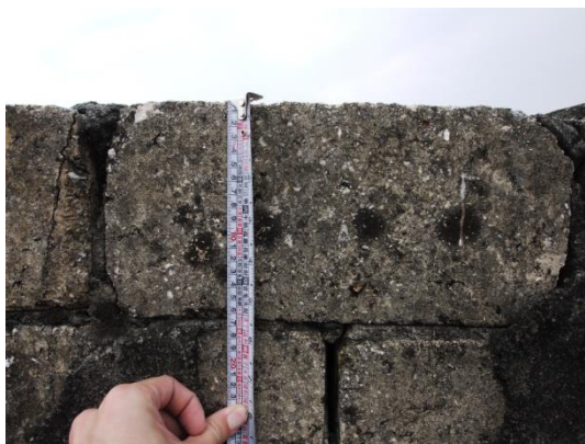
照片 4.1.9 空心磚高度約 16.5cm 、灰縫厚度約 1cm
