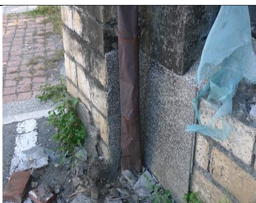
照片 3.2.49 避雷針接地線沿排水管接地
