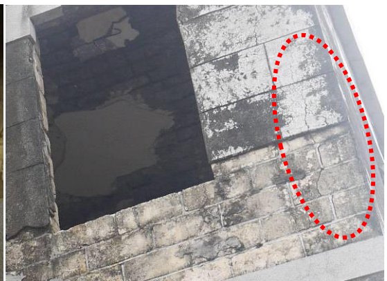
照片 4.2.8 混凝土空心牆轉角垂直開 裂
