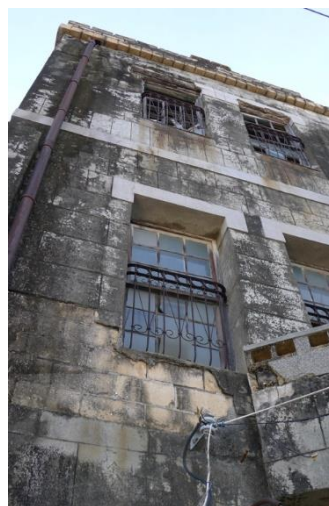
照片 3.3.46 洋樓東向建築外牆表面幾乎全面有污漬
