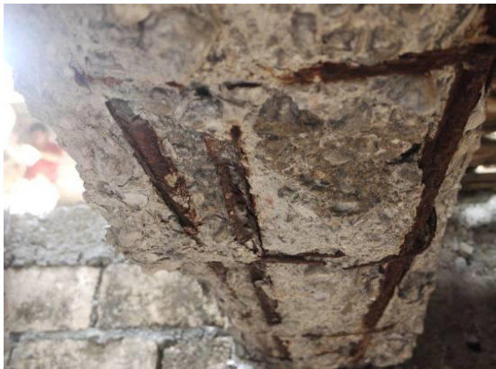
照片 4.2.5 一樓中廊 RC 樑鋼筋銹 蝕、保護層剝落
