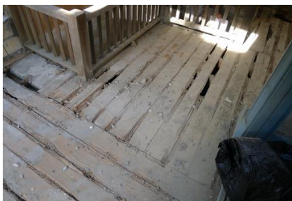
照片 3.3. 31 R2F-4 鋪面地板已有 破損，木格柵亦有腐朽蛀蝕
