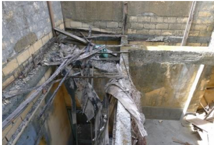
照片 3.3. 23 R2F-2 木樓地板已經佚失，殘留一些以破損木格柵地板的木構件
