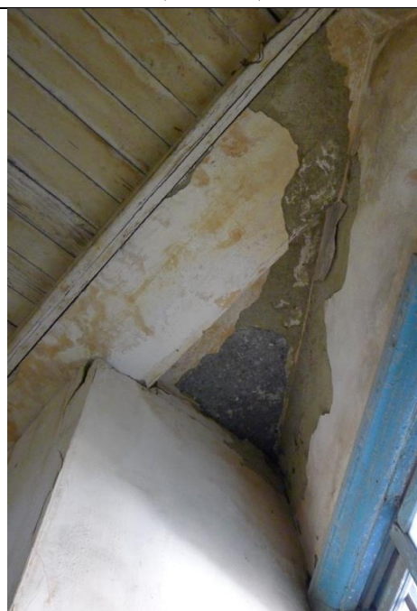
照片 3.3. 100 R1F-7 木作天花 有變形下垂，天花有小部分為 鋼筋混凝土面塗灰泥粉刷也都 有剝落現象
