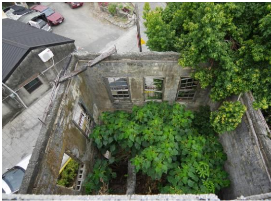
照片 4.2. 11 二樓西側居間上部木屋 架佚失，僅存少數敷桁、火打樑與錨定 螺栓，亦可見二樓木樓板構造佚失
