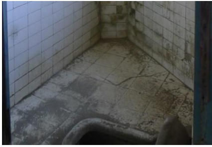
照片 3.3. 15 R1F-7 廁所空間地磚有裂縫破損
