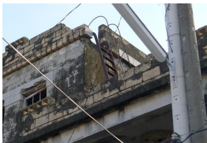
照片 3.3.49 東側外牆女兒牆垂流的水漬
