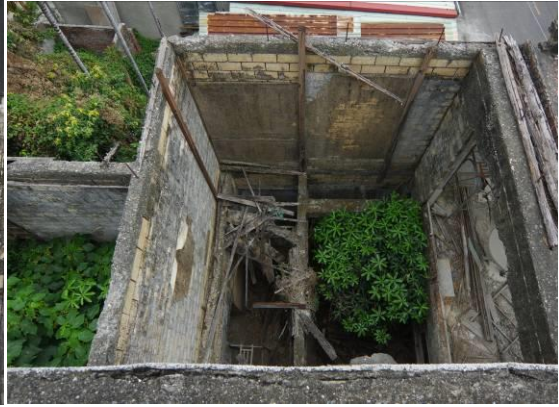
照片 4.2. 10 二樓北側臥室上部木屋 架佚失，僅存少數敷桁與錨定螺栓
