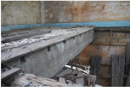
照片 4.1.20 RC 大樑上部側面具預留之根太嵌合孔(2015.03.16 拍攝)
