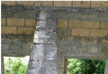
照片 3.3. 21 R2F-1 鋼筋混凝土梁上有木格柵梁嵌入的殘留構件
