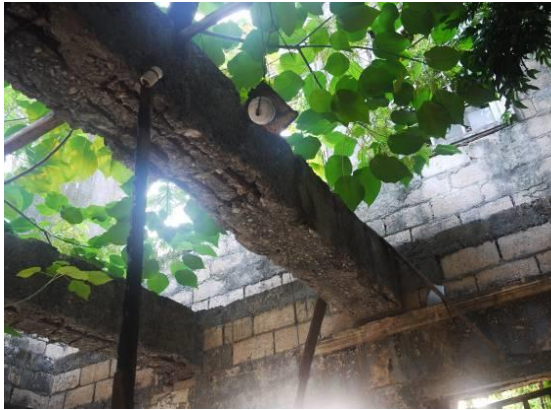
照片 4.2.3 西側量體二樓 RC 樑鋼筋 銹蝕、保護層剝落
