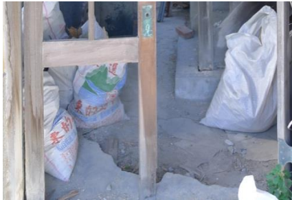
照片 3.3. 9 R1F-0 入口處磨石子地坪破裂並嚴重下陷
