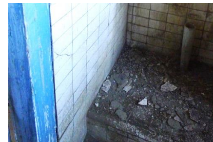
照片 3.3. 14 R1F-7 盥洗空間，地坪有設置排水管。
