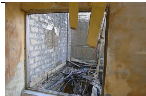
照片 3.2.40 二樓左右橫拉的方式開啟，門框留有凹槽軌道
