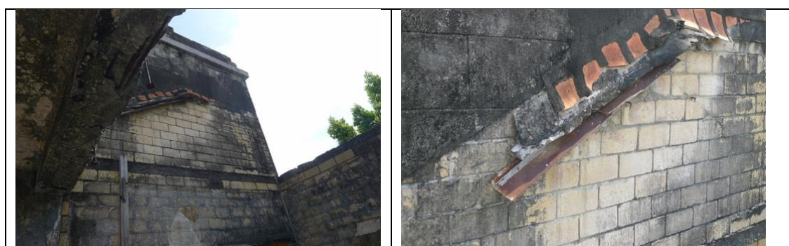
照片 3.3. 161 南側牆面留有一些斜屋頂和空心磚接合的瓦片
