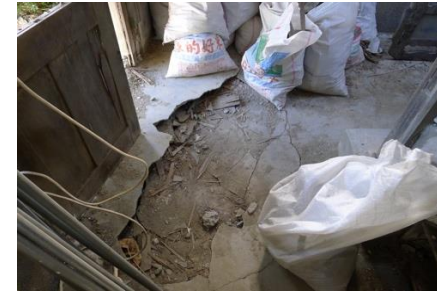
照片 3.3. 10 R1F-0 入口處磨石子地坪破裂並嚴重下陷
