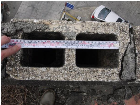
照片 4.1.7 內部長向開孔寬約 12.5cm、腹部厚度約 3cm
