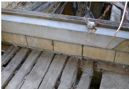
照片 3.3. 29 R2F-4 通往和式的鋪 面地板破損情形
