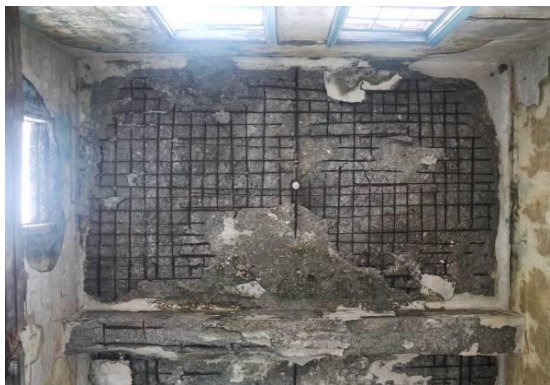
照片 4.2. 1 南側主樓 RC 頂板鋼筋銹蝕、保護層剝落
