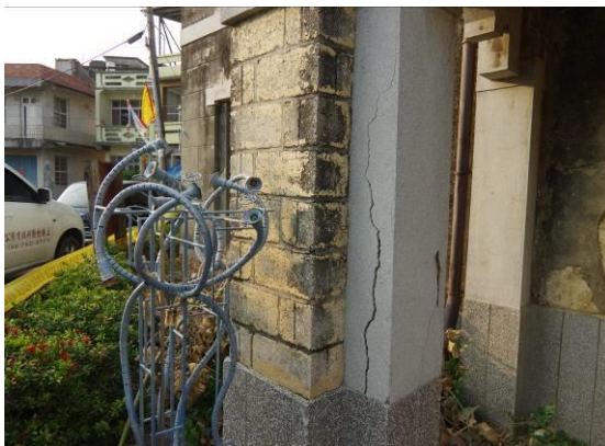
照片 4.2.7 入口玄關 RC 附壁柱鋼筋 銹蝕造成保護層開裂
