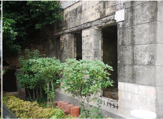
照片 4.2.4 窗頂楣樑鋼筋銹 蝕、保護層剝落
