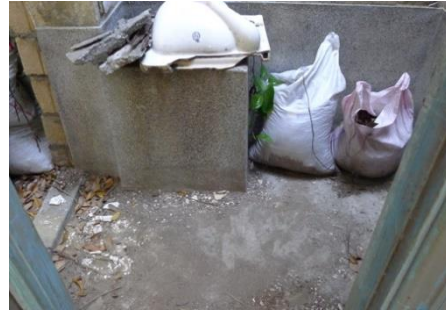
照片 3.3. 8 R1F-4 洗手台為洗石子表面
