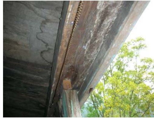
簷樑為方形斷面，以搭配屋頂與窗框構造
