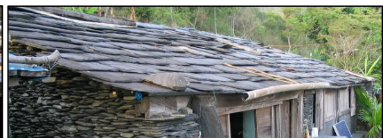
簷桁前側設置天溝
