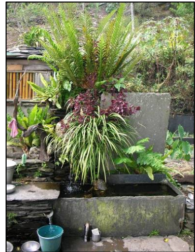
以水管引水至水槽內，再利 用水管及轉接頭連接至廁所 之水龍頭 (家屋編號 6 翁秋英， 2006)
