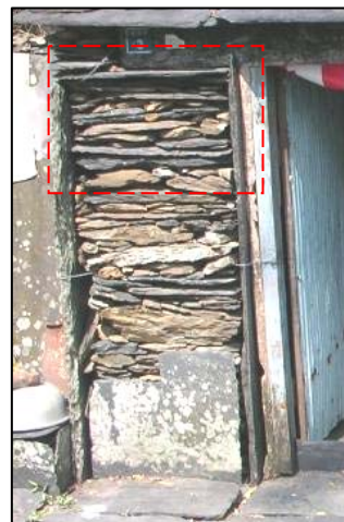
上層放置較大片之石板
