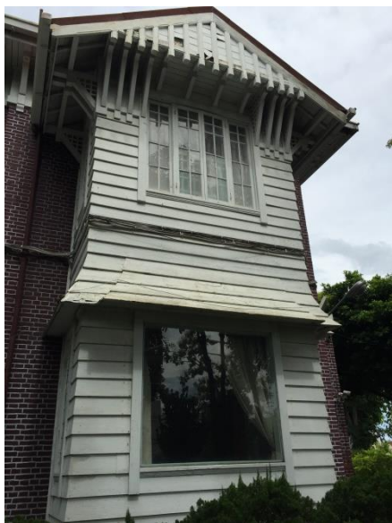
【圖 3-62】洋館「凸窗」形制及對外雙開的木製格子窗大面玻璃封實景觀窗
