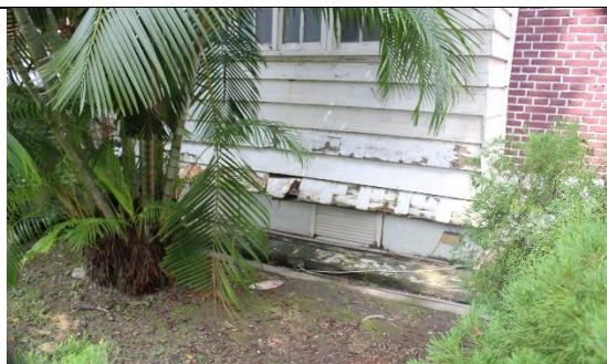
英式雨淋板脫漆、汙損
