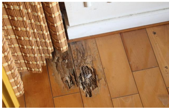
【圖 3-32】和館重鋪地板損毀狀況
