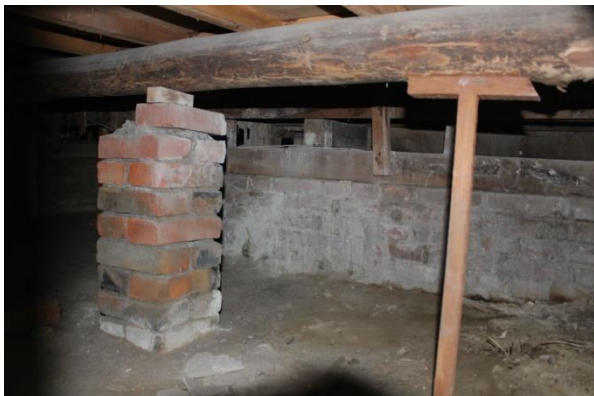
【圖 3-26】和館承重構造下方砌 1B 磚
