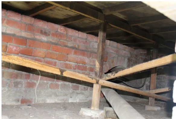
【圖 3-52】最外圍承重部分採連續磚牆
