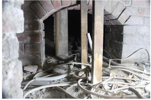
【圖 3-51】圈拱狀造型通氣孔
