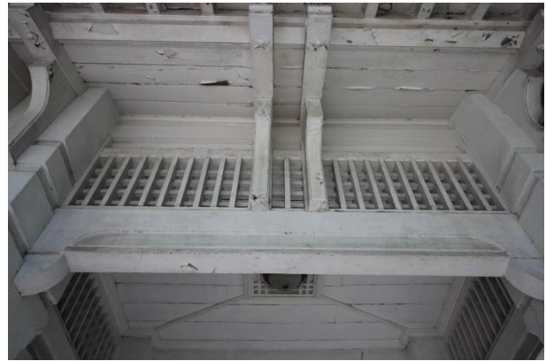
【圖 3-65】洋館入口木造格柵式構造的柱頭線盤牆
