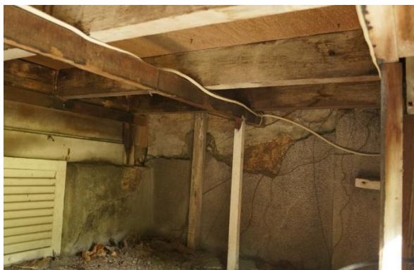
【圖 3-29】和館後側緣更換之床板及根太
