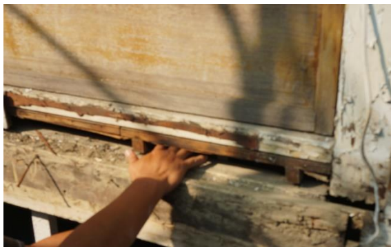
【圖 3-31】和館重鋪地板原始地坪之落差
