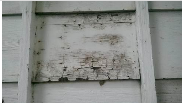
雨淋板破損，底板中空腐朽嚴重
