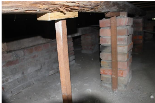
【圖 3-27】和館承重構造下方砌磚通氣孔
