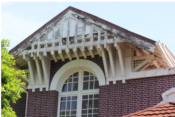
【圖 3-69】洋館破風板下方木造格柵簷欄
