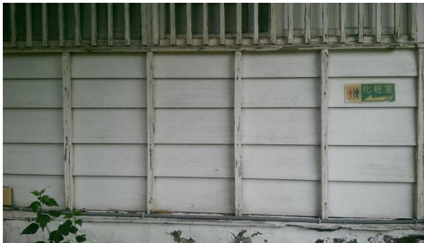
【圖 3-34】和館押緣雨淋板(簷子下見板張)
