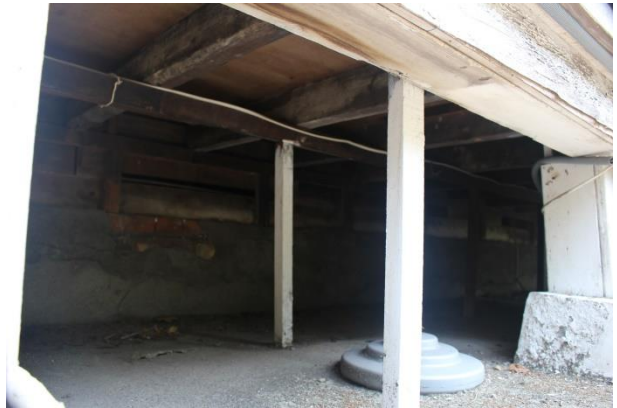
【圖 3-23】和館後側緣床組構造
