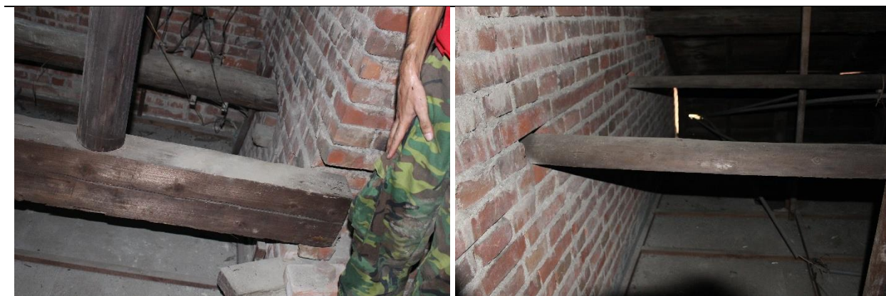
【圖 3-19】和館及洋館介面屋架搭接狀況
