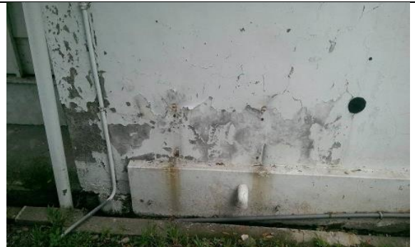
增建外部水泥牆，油漆脫落
