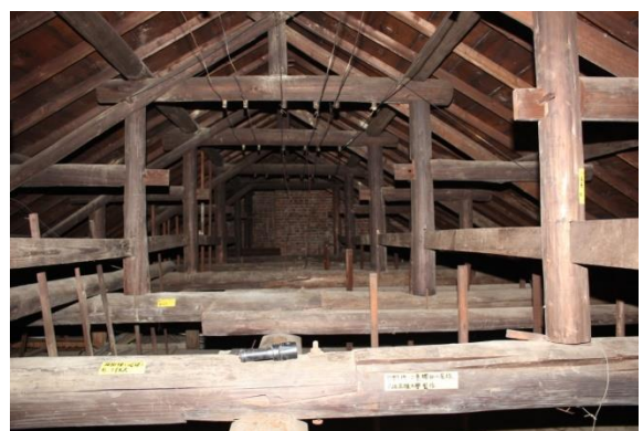
【圖 3-39】和館二重樑小屋構造照片
