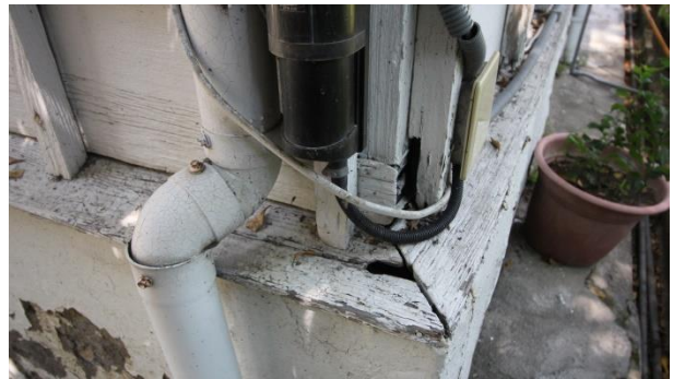
【圖 3-35】和館押緣雨淋板(簷子下見板張)收邊
