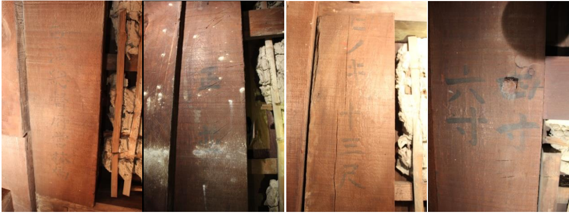
【圖 3-80】台灣總督府營林局扁柏角材，斷面四寸六寸，長十三尺，等級：並
